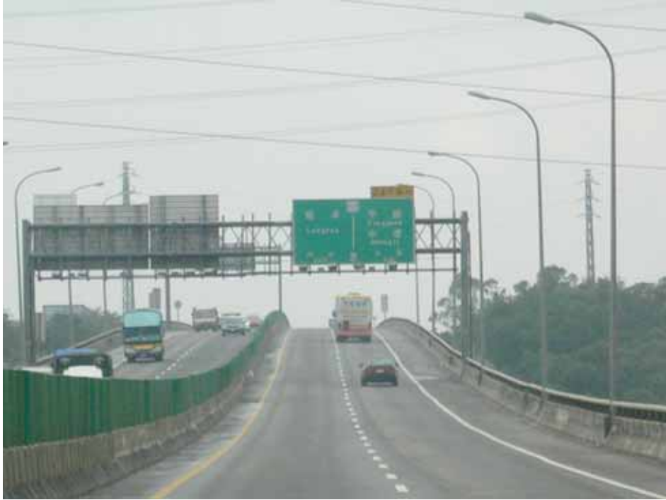
圖 A4.3-1 門架式標誌桿例圖
