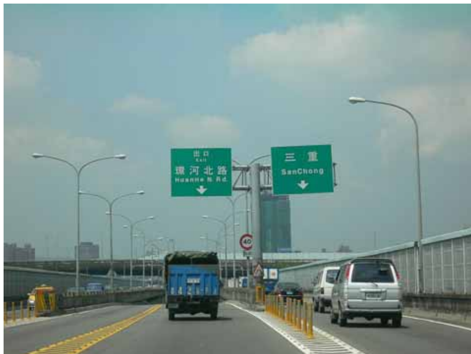
圖 A4.2-8 雙 F 型懸臂式標誌桿例圖
