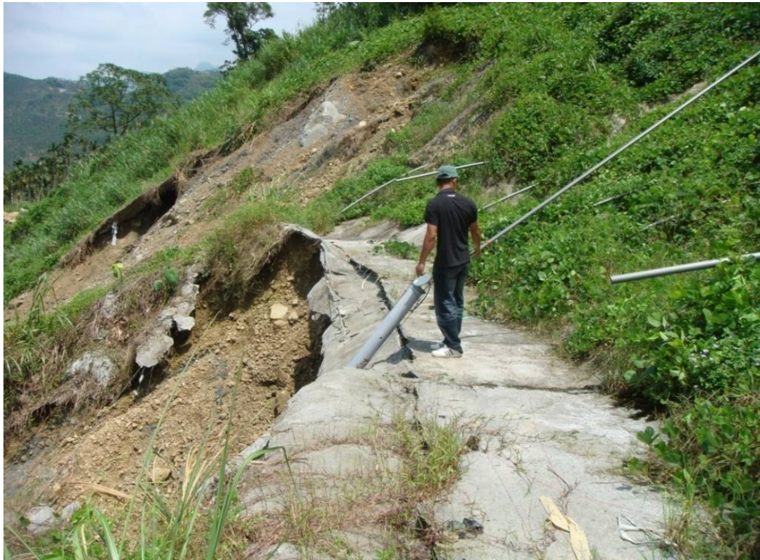
圖 3.1 GPS8 基座崩塌
