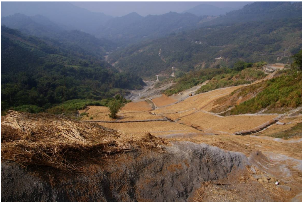
圖 3.3 GPS 監測區災前護坡工程
