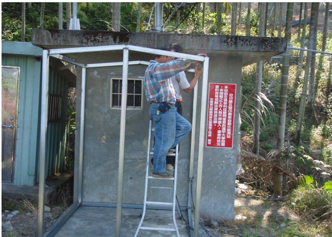
圖 3.14 發電機房施工照片
