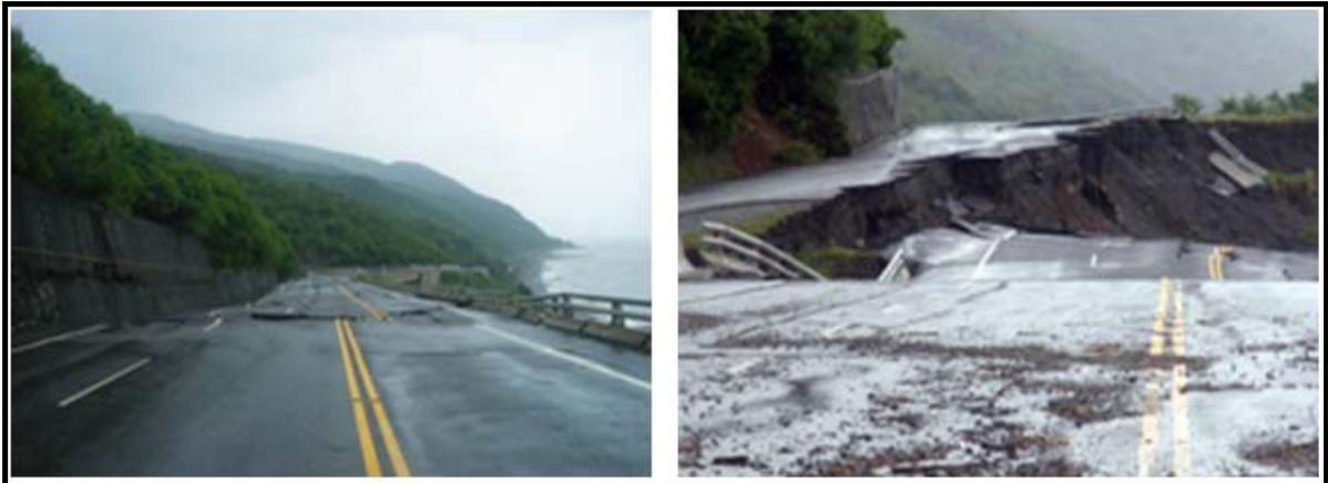
圖 5.4.9 臺 9 線 429K+800~430K 路面塌陷災害
