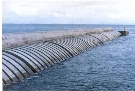
圖 4.1.5 凸型曲面防波堤（日本船川港）
