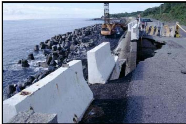
圖 5.1.3 海岸公路嘉平段路面塌陷情形
