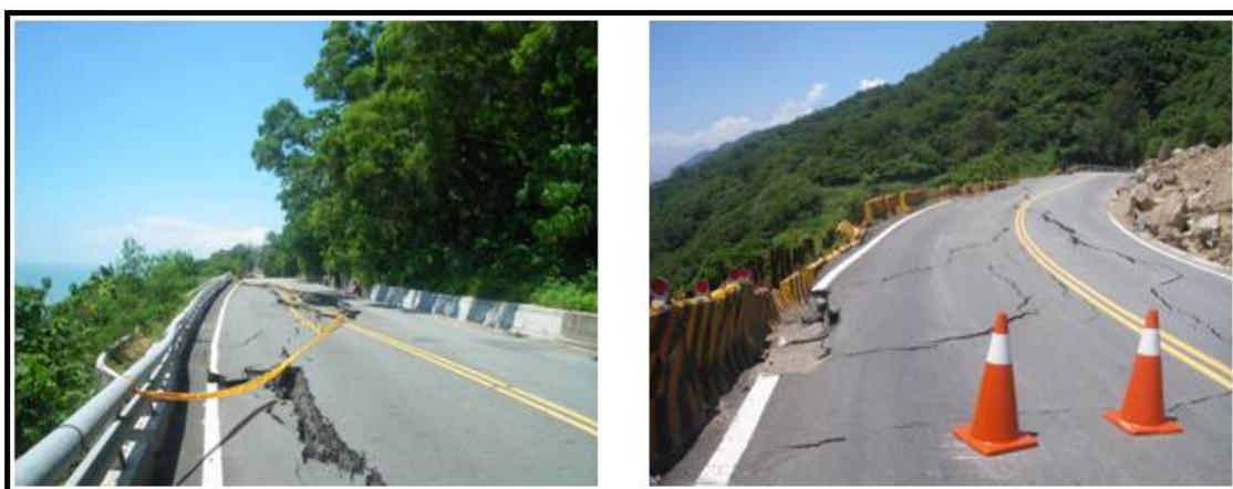
圖 5.4.8 臺 9 線 410K+650(左)及 411K+150 路面塌陷災害
