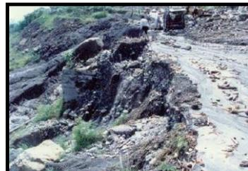
此段為大崩段，地質包含了凝灰岩和泥岩...等。凝灰岩膠結性不佳，孔隙率大，風化快；泥岩則是遇水則軟化。因此處有了這兩種地質特徵，所以此處形成了台11線的大崩段。經四工處證實，該段道路崩塌之情況，趨於減緩。
