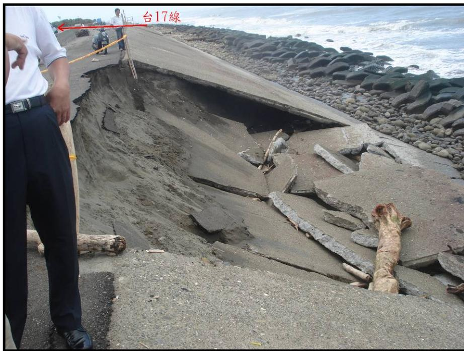
圖 5.4.11 臺 17 線臺南黃金海岸段邊坡護岸破壞情形
