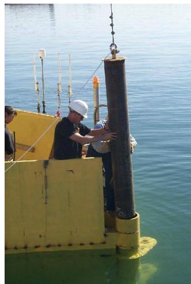
圖 3.1.3 大型 RIBS 的基本組件及安裝
