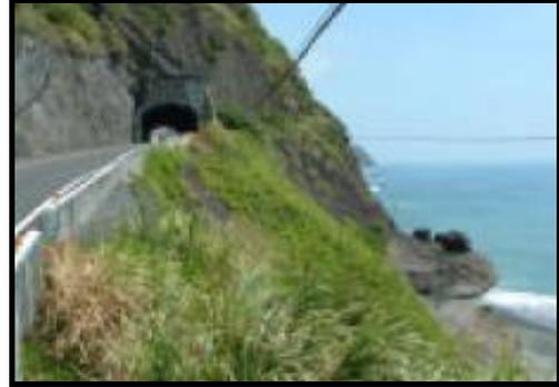
該段有設置新機隧道，但因地質多為舊崩積土，加上離海近，路基易被海岸侵蝕淘刷，進而產生崩塌。目前四工處已將此段內縮 100m，現今仍在施工中。
