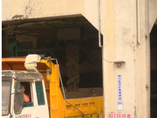
照片 3.3 新拌透水混凝土卸料至卡車之情況
