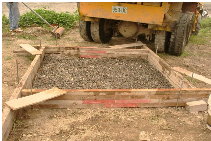
照片 3.4 試鋪時模版組立與碎石鋪設情形
