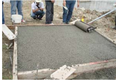
照片3.12透水混凝土滾筒壓密與完成面之施作
