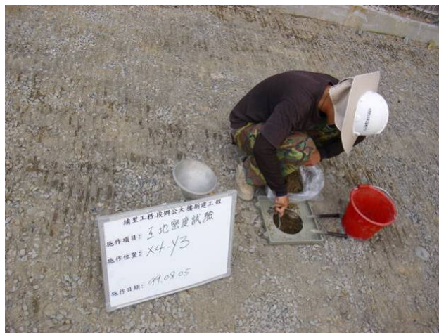
照片 4.3 底層工地密度試驗之進行
