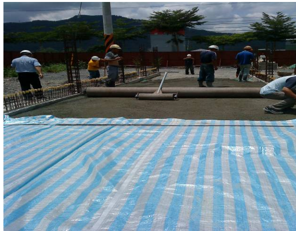
照片 4.22 塑膠布覆蓋養護新拌透水混凝土鋪面
