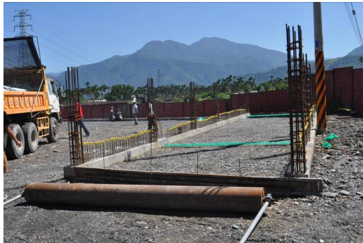
照片 4.5 底層碎石級配完成
