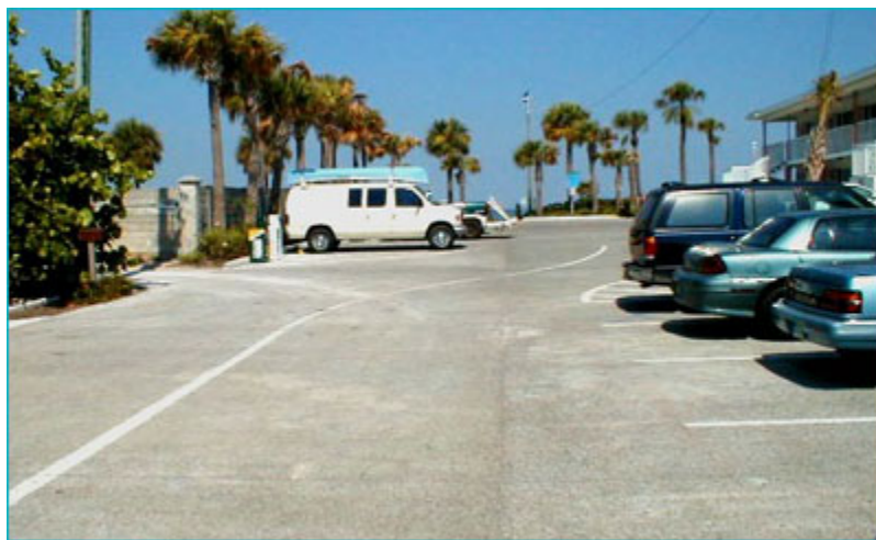
照片 2.1 美國透水鋪面應用於停車場【1】
