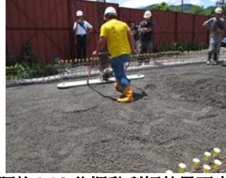
照片4.16 此振動刮板效果不良
