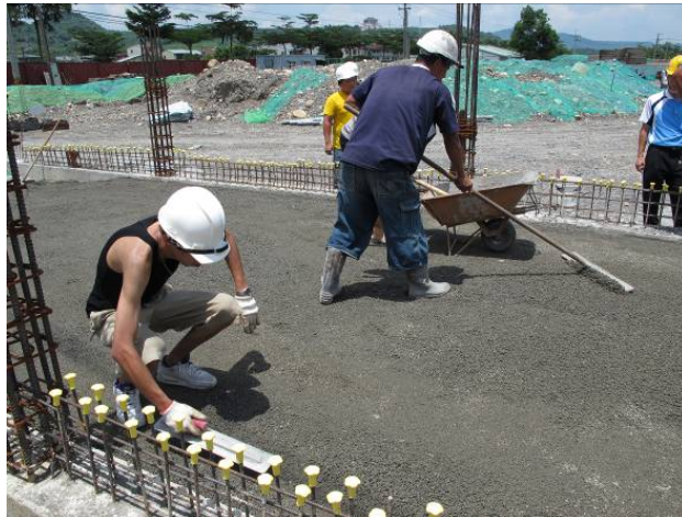
照片 4.20 鋤刀邊飾透水混凝土以改善角落邊緣外觀
