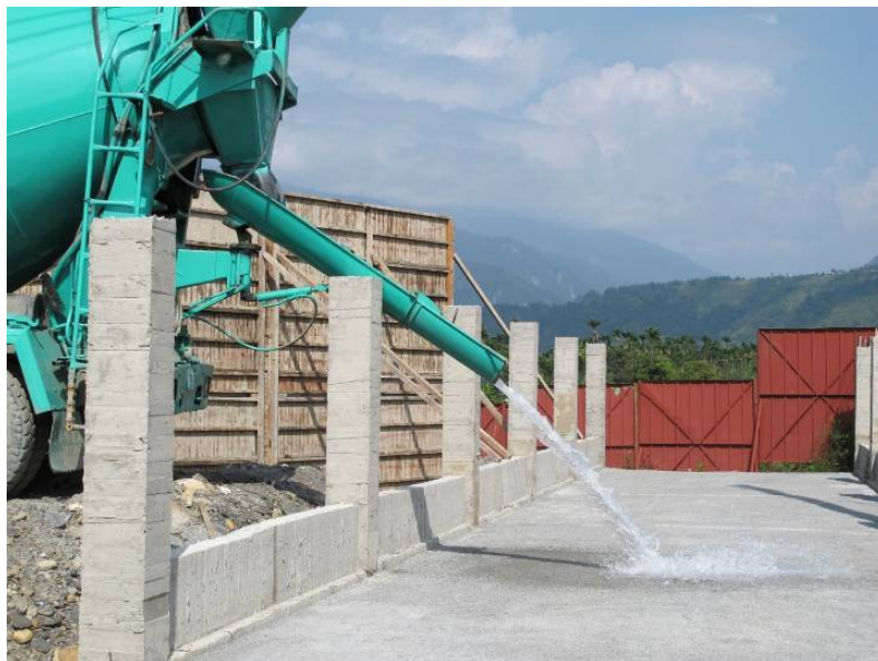
照片 5.16 預拌車裝滿水灌水至透水混凝土鋪面之情形
