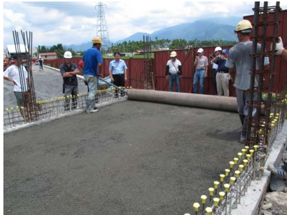
照片 4.17 透水混凝土使用大滾筒滾壓情形
