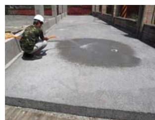
照片4-28 現地自來水水管透水能力測試
