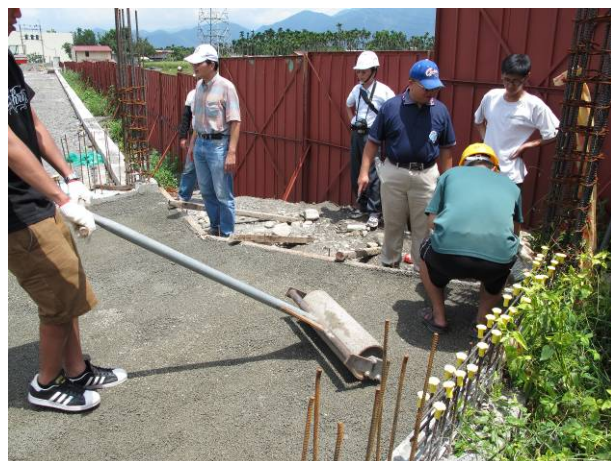
照片 4.18 透水混凝土使用小滾筒滾壓情形
