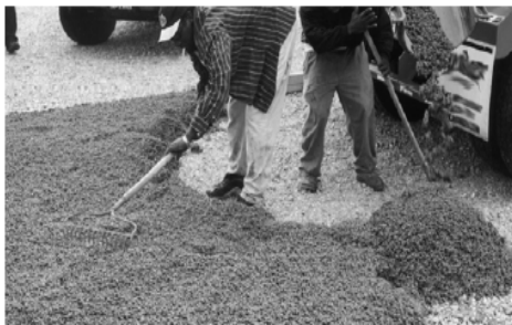
透水混凝土卸料、澆置、攤平施工
