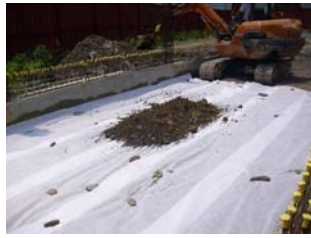
照片4.2 基層不織布鋪設完成
