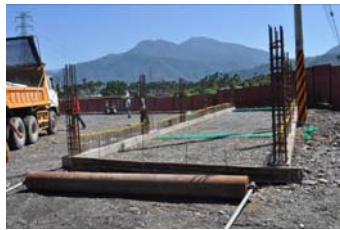
照片4.5 底層碎石級配完成
