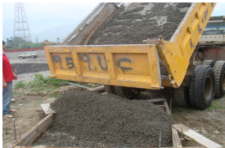
照片 3.5 透水混凝土由卡車卸料至試鋪基地
