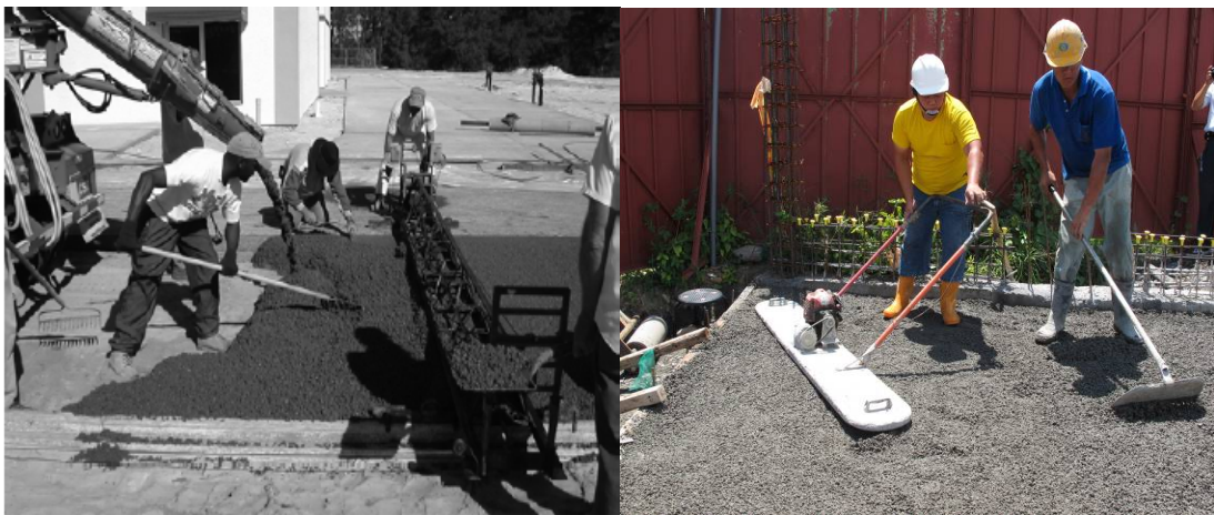
照片 5.10 預計中震動刮板與當天實際使用之刮板
