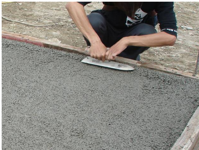
照片 3.9 鏟刀邊飾透水混凝土以改善角落邊緣外觀
