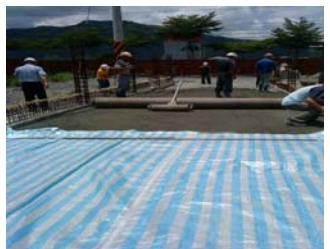
照片4.22 塑膠布覆蓋養護情形
