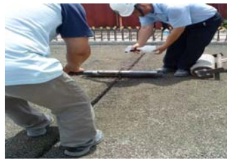
照片4.21 使用滾筒刀片切縫情形
