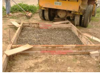
照片3.8試鋪時模版組立與碎石鋪設情形
