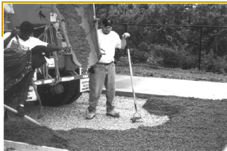
透水混凝土卸料、澆置、攤平施工
