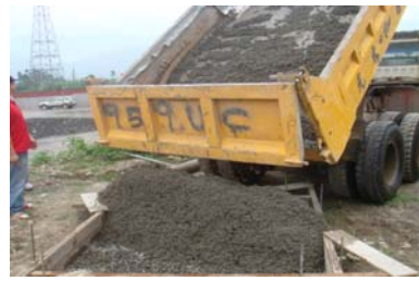
照片3.9透水混凝土由卡車卸料至試鋪基地
