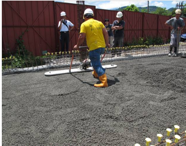
照片 4.16 振動刮板其刮平與振動搗實之效果不良
