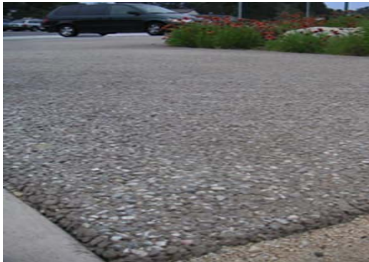
照片 2.8 南加州 Manhattan Beach 透水混凝土停車場 (42)
