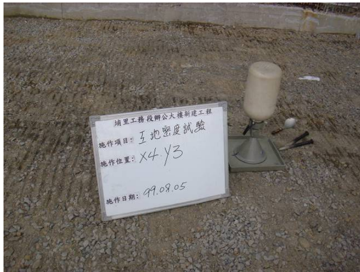
照片 4.4 底層工地密度試驗完成
