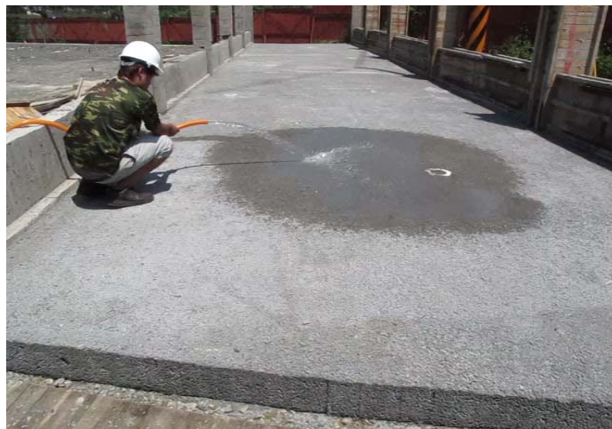
照片 4.28 現地自來水管透水能力測試
