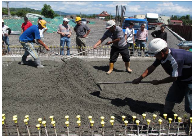
照片 4.13 透水混凝土澆置與攤平之情形
