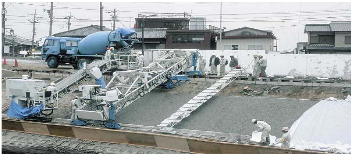
照片 2.5 透水混凝土護坡施工澆置情形 (GOMACO 公司) (12)
