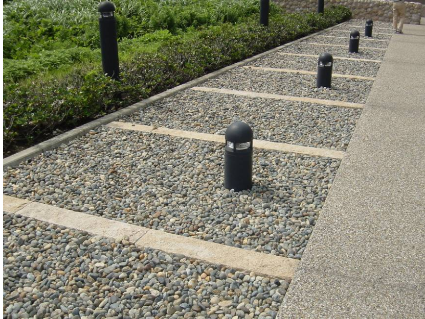
照片 2.3 日本透水鋪面應用於步道 (1)
