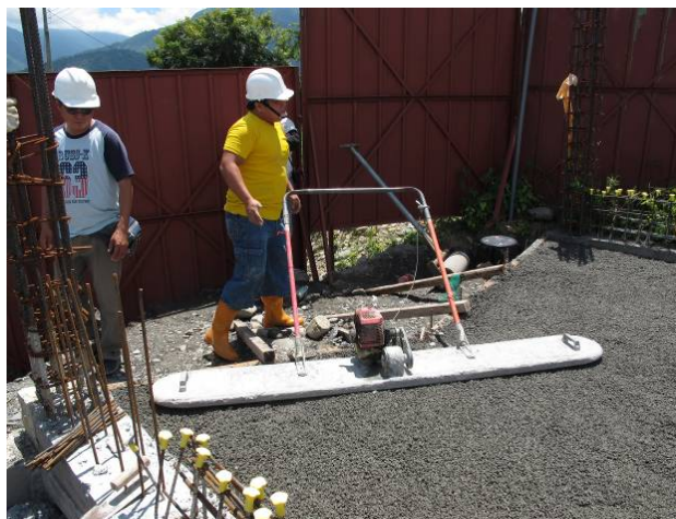
照片 4.15 現場工程人員刮平與振動搗實之情形
