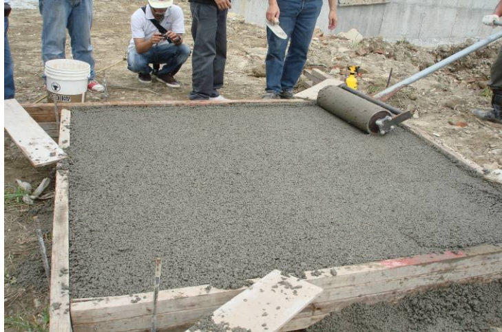
照片 3.8 透水混凝土滾筒壓密與完成面之施作
