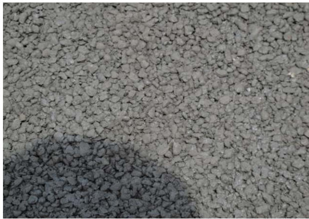
照片 4.19 透水混凝土最終壓實之情形
