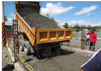
照片4.11 透水混凝土由卡車卸料
