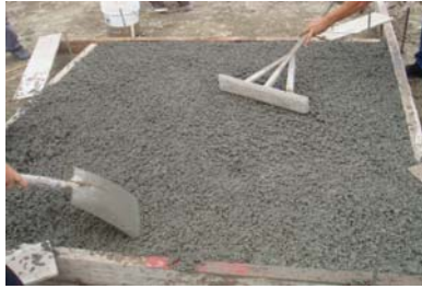
照片3.11使用鏟子與推平扒攤平新拌透水混凝土
