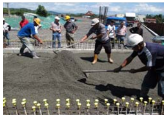
透水混凝土澆置與攤平
