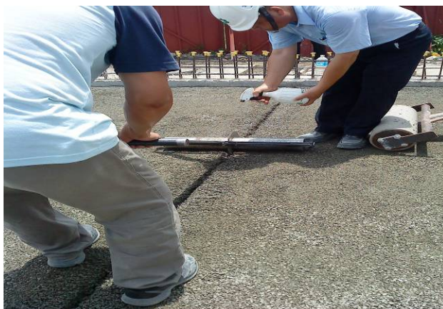
照片 4.21 新拌透水混凝土鋪面使用滾筒刀片切縫之情形
