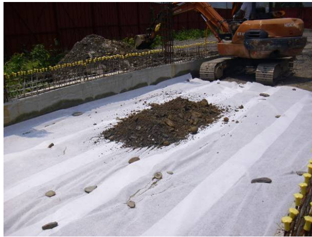
照片 4.2 基層不織布鋪設完成
