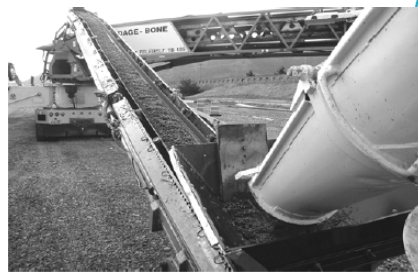
透水混凝土卸料、澆置、攤平施工
