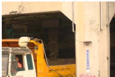
照片3.7新拌透水混凝土卸料至卡車之情況
