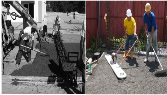
照片6.10 預計中震動刮板與當天實際使用之刮板
