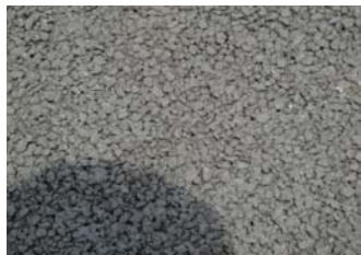
照片4.19 透水混凝土最終壓實情形
