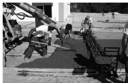
透水混凝土卸料、澆置、攤平施工
