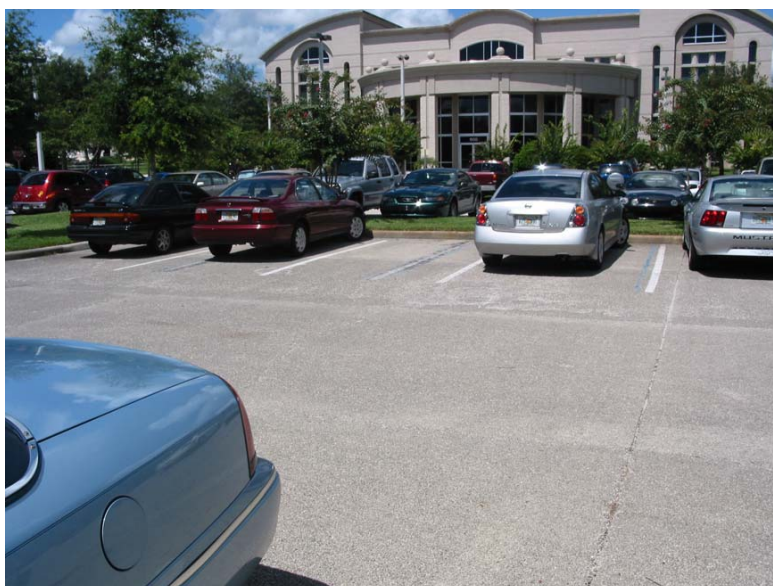
照片 2.10 Strang Communication Office 透水混凝土停車場 (43)
