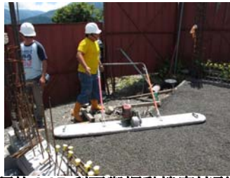
照片4.15 刮平與振動搗實情形
