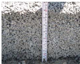
鋪設厚度符合設計厚度20cm
