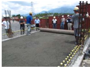
照片4.17 使用大滾筒滾壓情形
