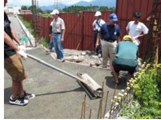
照片4.18 使用小滾筒滾壓情形
