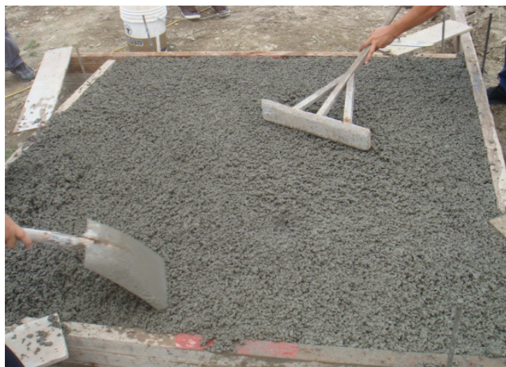
照片 3.7 使用鏟子、耙子與推平扒攤平新拌透水混凝土
