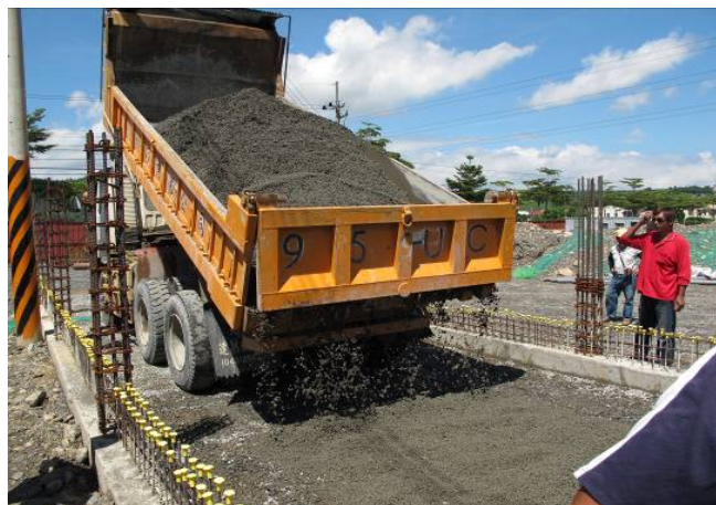
照片 4.12 透水混凝土由第二回卡車卸料情形
