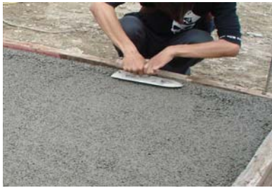
照片3.13鏟刀邊飾透水混凝土以改善角落邊緣外觀
