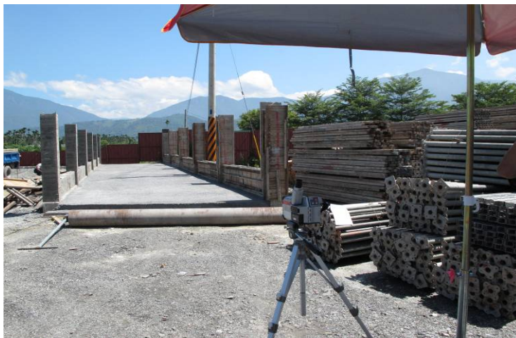
照片 5.8 9 月 8 號透水道路之拍攝情形
