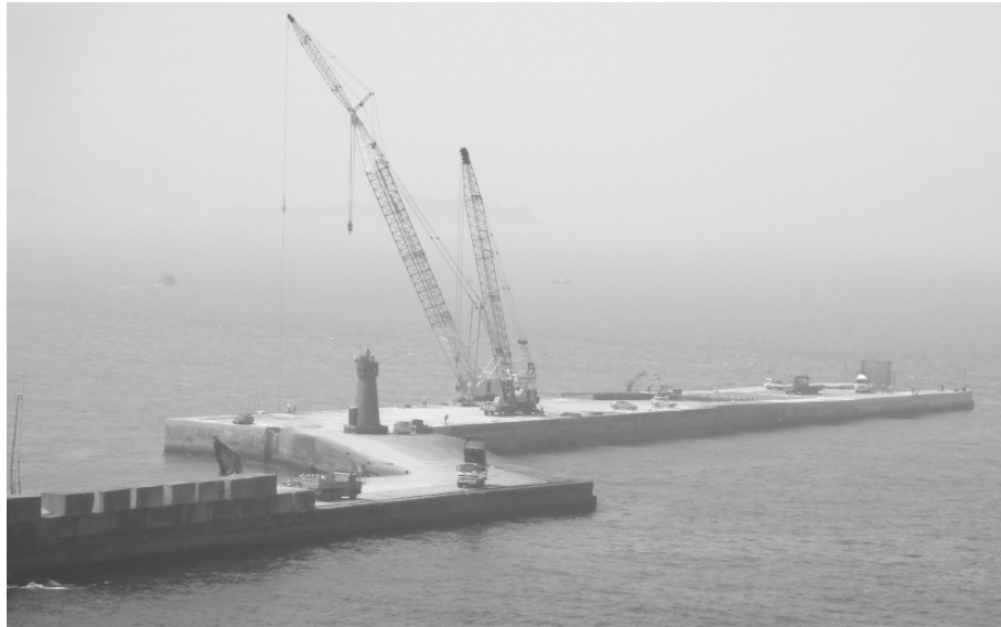
圖 3.1 基隆港東防波堤延伸工程施工近況
