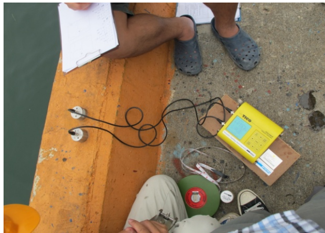
圖 3.17 護欄裂縫量測情形
