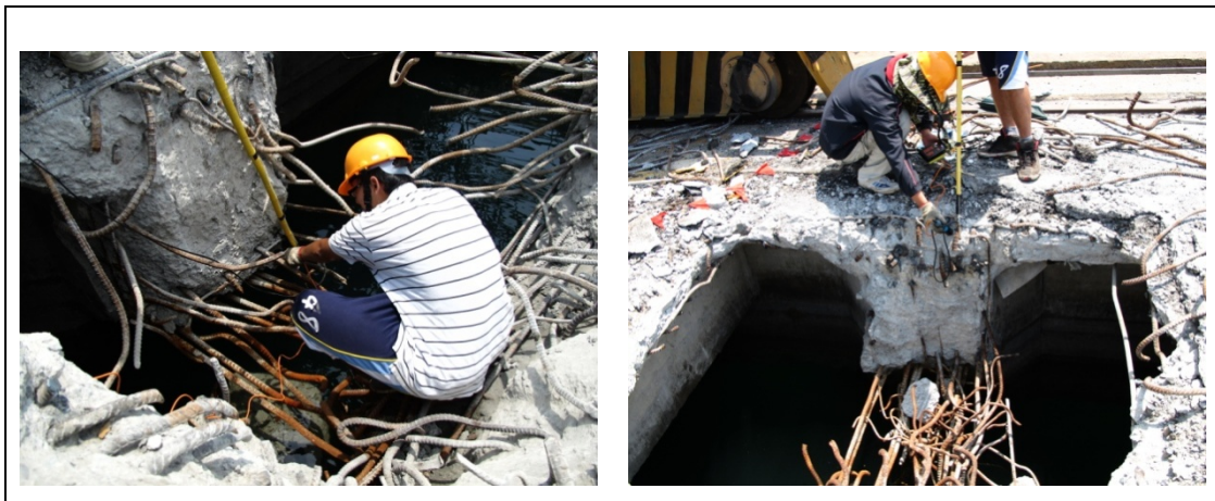
圖 3.20 鋼筋腐蝕電位量測情形
