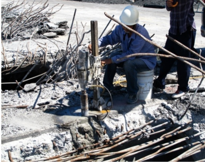
圖 3.8 現場鑽心取樣情形
