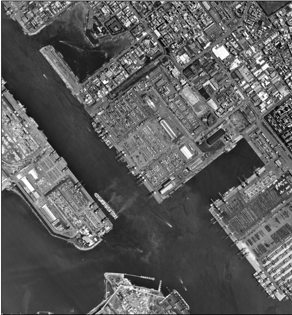
照片1.1 高雄港區第四貨櫃中心之棧橋式碼頭之空照圖
