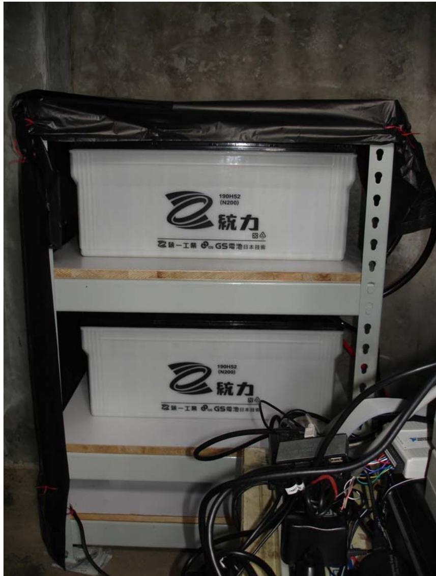
圖 3.13 高供電量(4800W)不斷電系統
