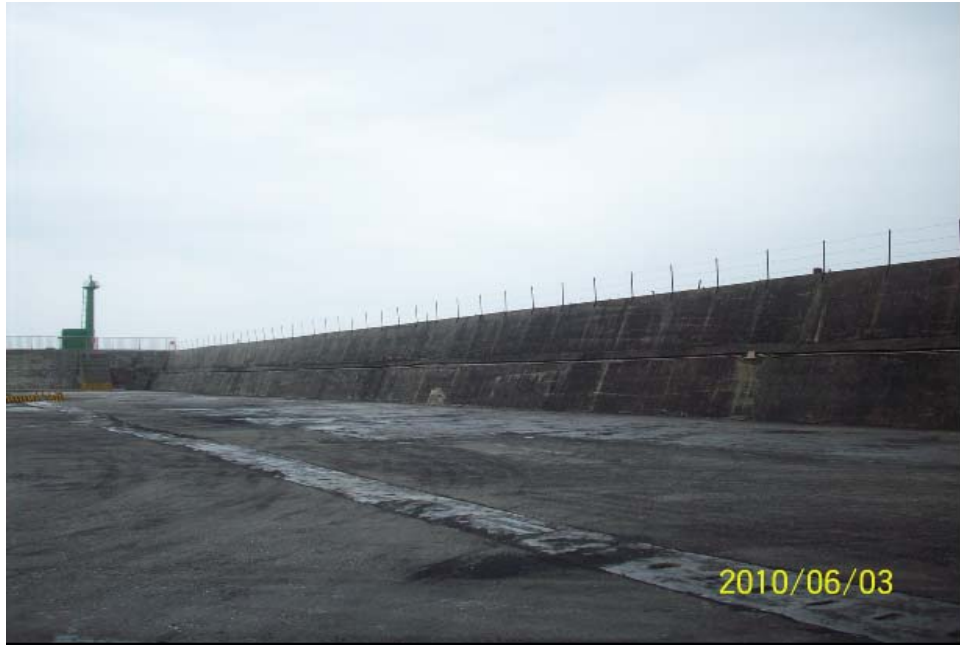
圖 3.26 花蓮港務局西防波堤
