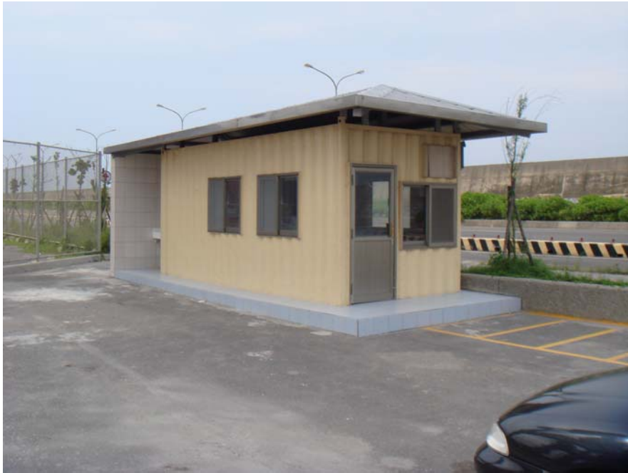
圖 4.8 臺北港北 2 碼頭工寮現況
