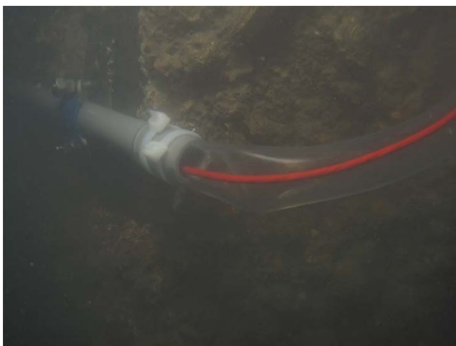
圖 4.4 水下訊號線固定
