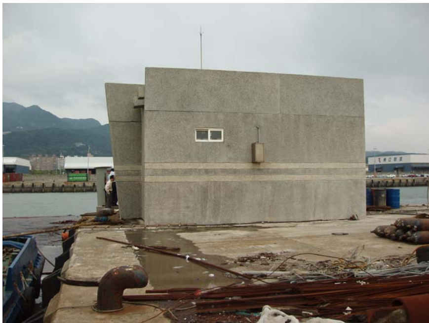
圖 3.4 TPE09 驗潮站外部周圍現況
