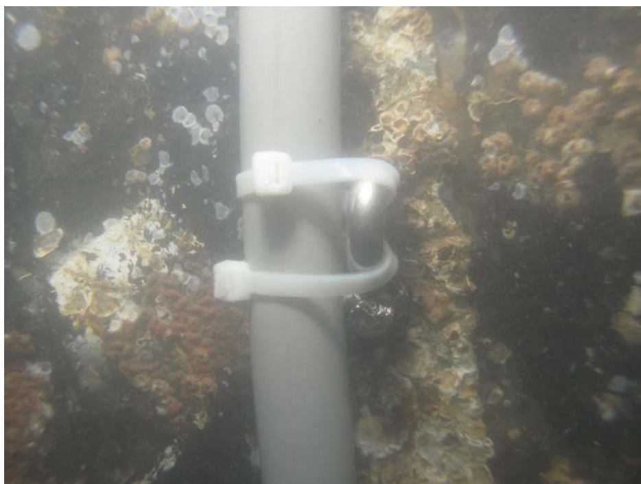
圖 4.3 動態剖面位移計水下安裝完成圖
