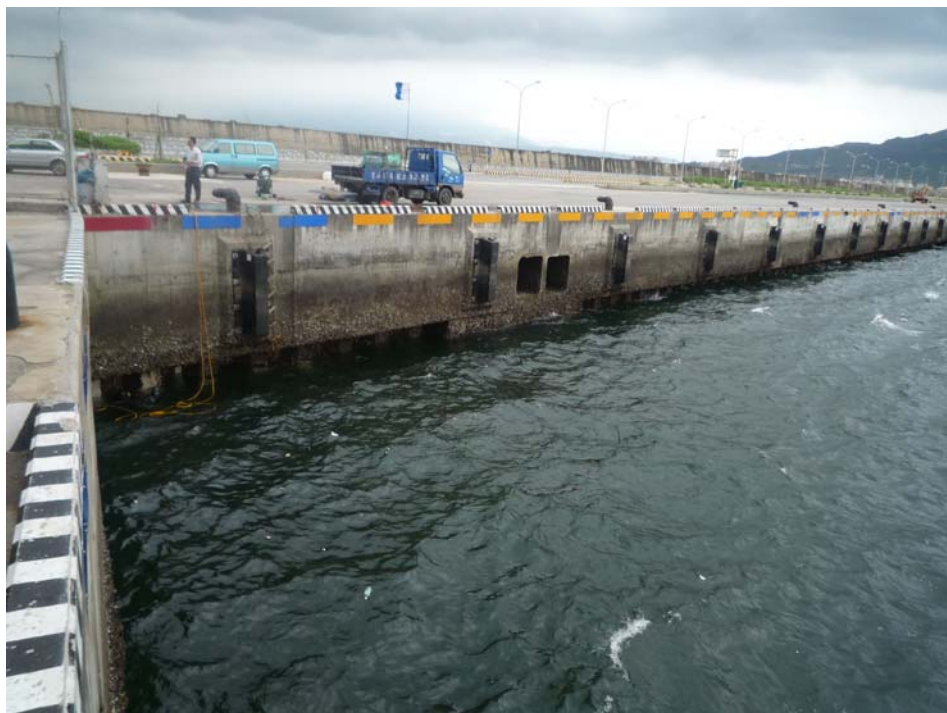
圖 3.7 臺北港北 2 錨碇式版樁碼頭現況
