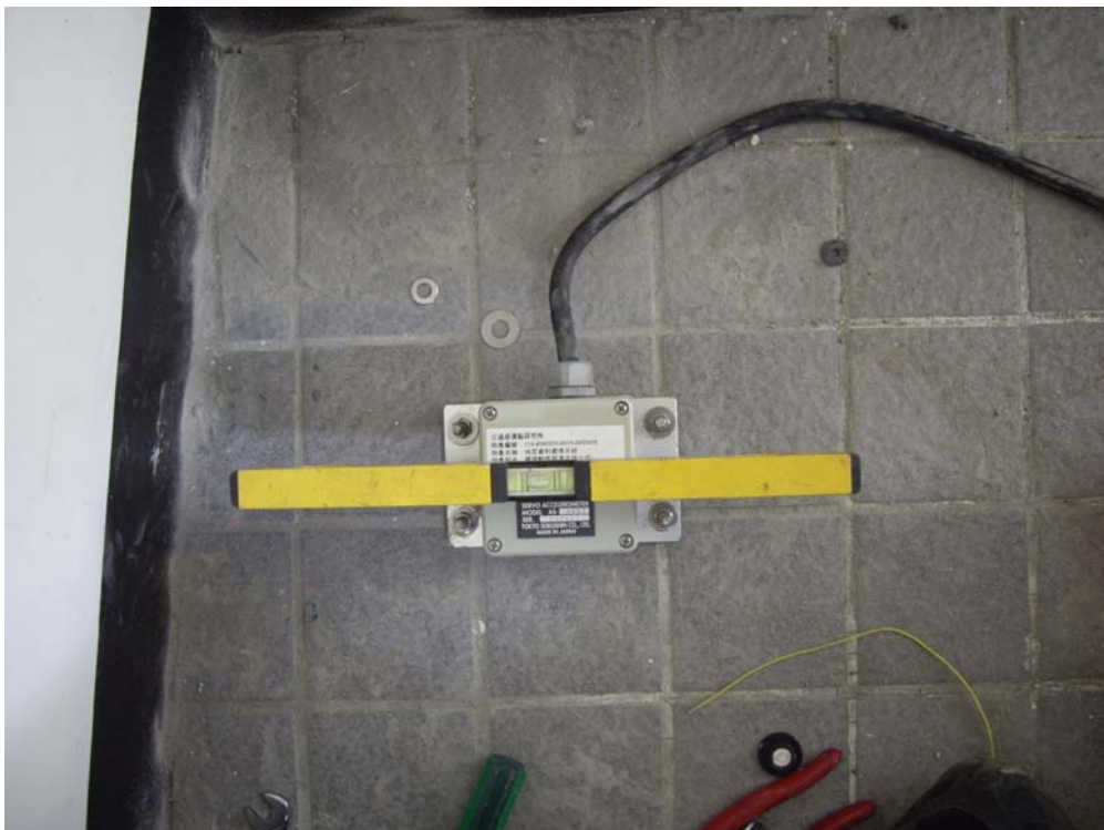
圖 4.6 陸上地震儀安裝
