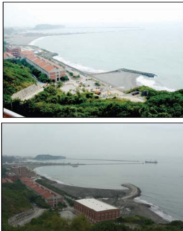
圖 3.1 西子灣人工岬灣及養灘施作前後圖 (上：完工前，下：完工後-97 年 7 月初)
