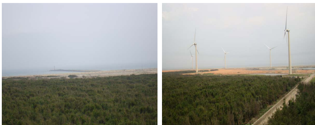
圖 5.1 台中港北防波堤與北防砂堤之間海域現況圖
