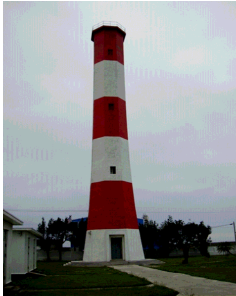
圖 5.2 台中港高美燈塔
