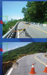
臺9線410K+650(左)及411K+150路面塌陷災害
