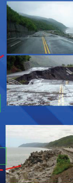
臺9線429K+800~430K路面塌陷災害
