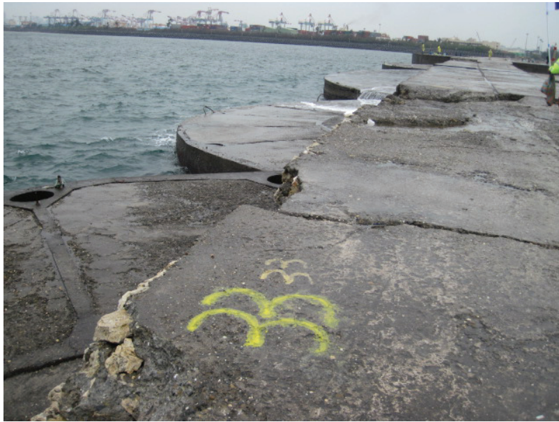
圖 4.5.2 北堤沉箱#33、#34 堤面現況
