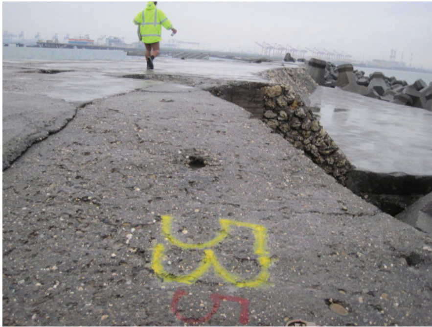
圖 4.5.4 南堤沉箱#53 堤面現況
