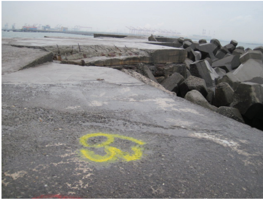
圖 4.5.6 南堤沉箱#63、#64 堤面現況
