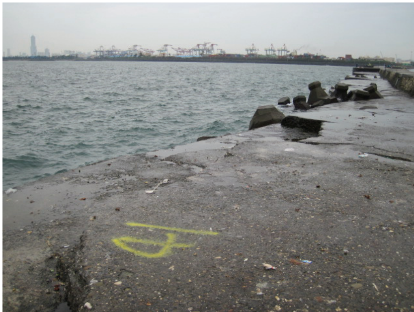
圖 4.5.3 北堤沉箱#41 堤面現況
