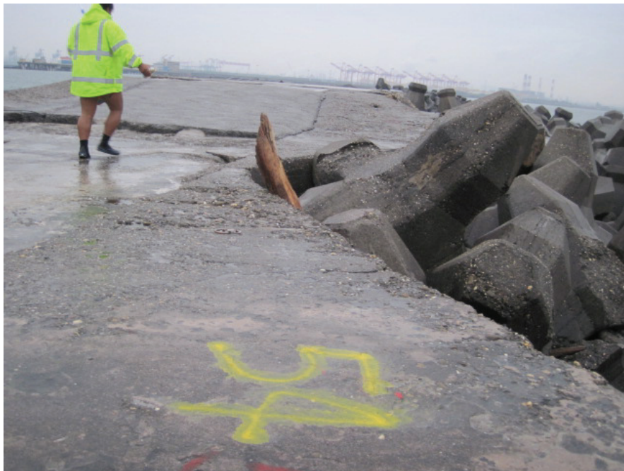
圖 4.5.5 南堤沉箱#54 堤面現況
