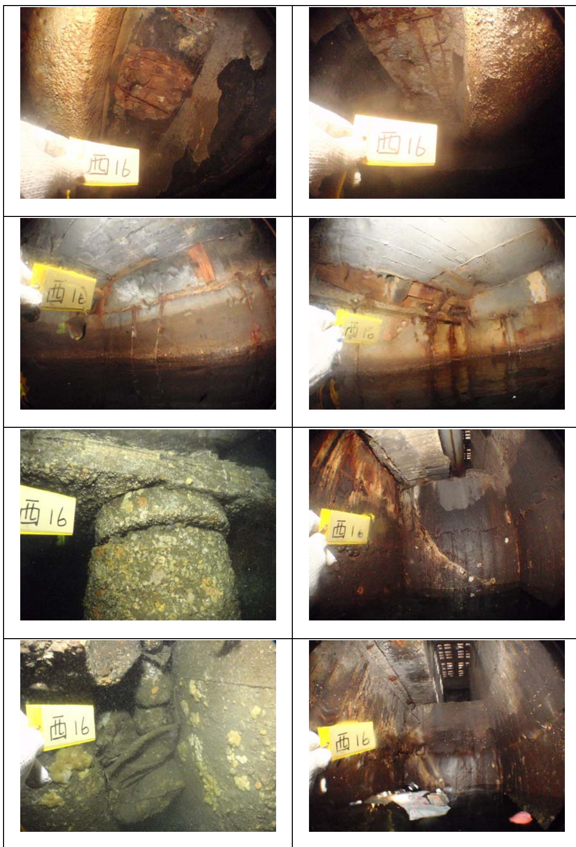
圖 32 基隆港西 16 號碼頭新舊交接處現況調查照片
