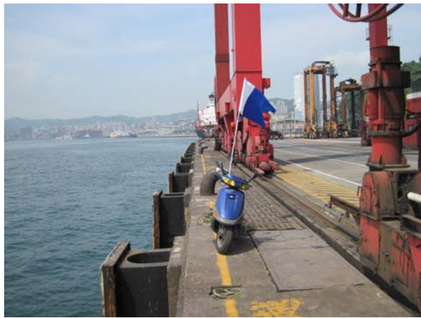
圖 33 基隆港西 17 號碼頭碼頭上部結構現況
