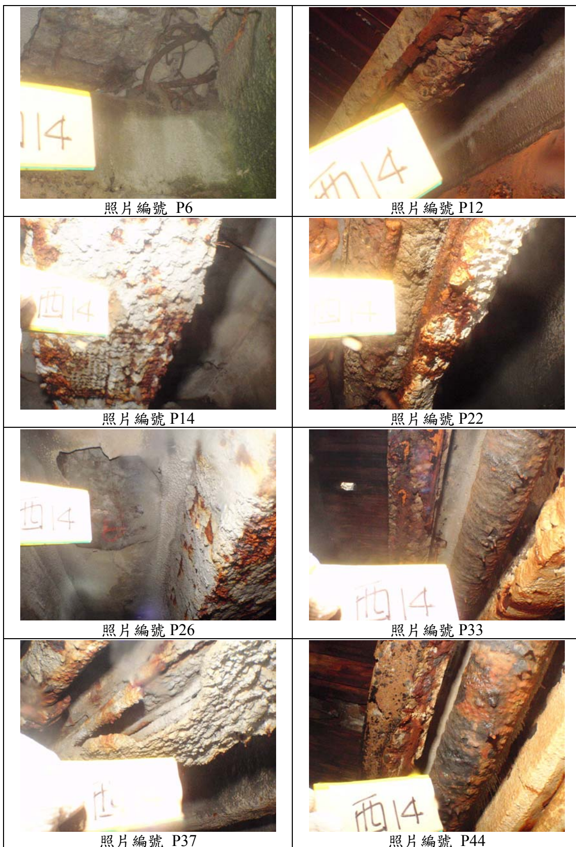
圖 25 基隆港西 14 號碼頭基樁式面版調查照片
