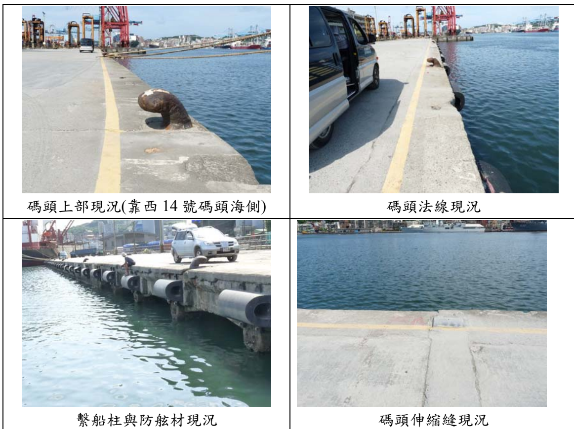
圖 26 基隆港西 15 號碼頭上部結構現況
