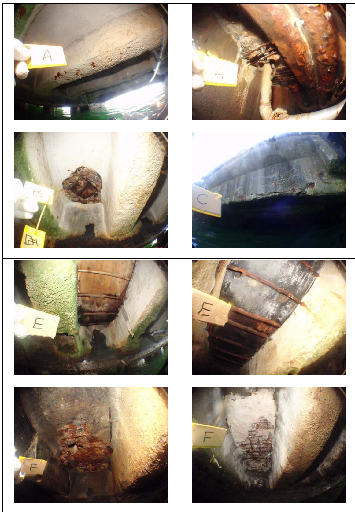
圖 29 基隆港西 15 號碼頭基樁式面版調查照片
