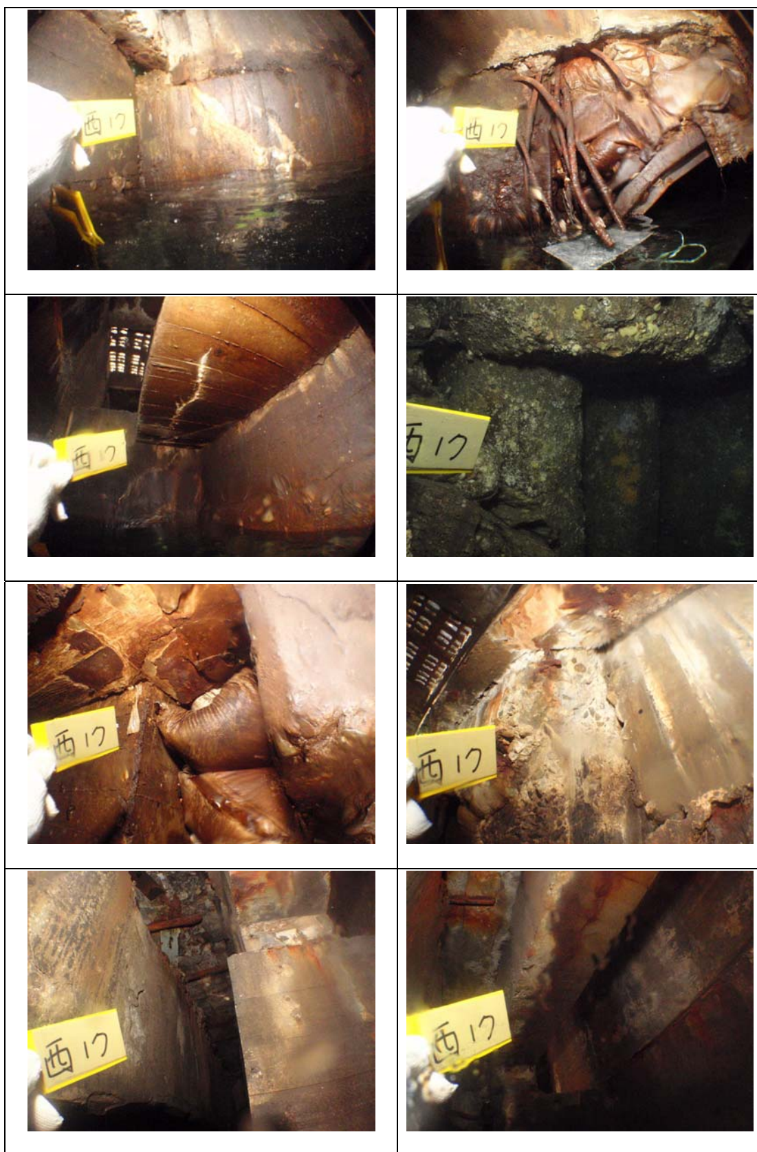
圖 34 基隆港西 17 號碼頭新舊交接處調查照片
