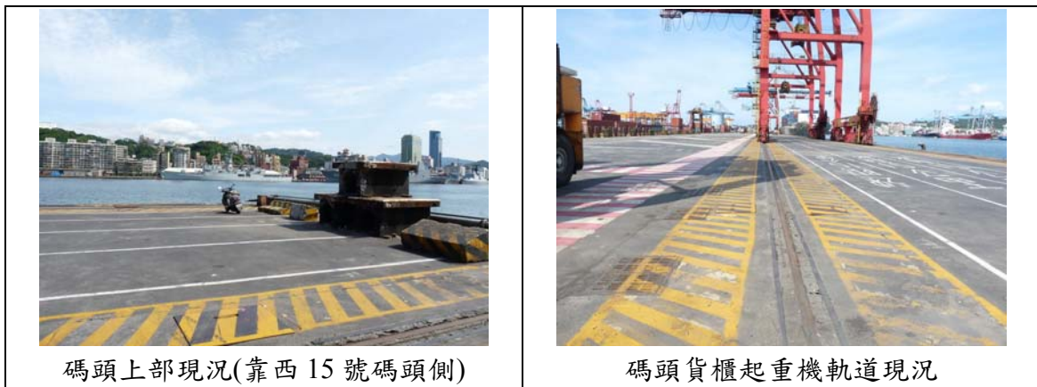
圖 31 基隆港西 16 號碼頭上部結構現況
