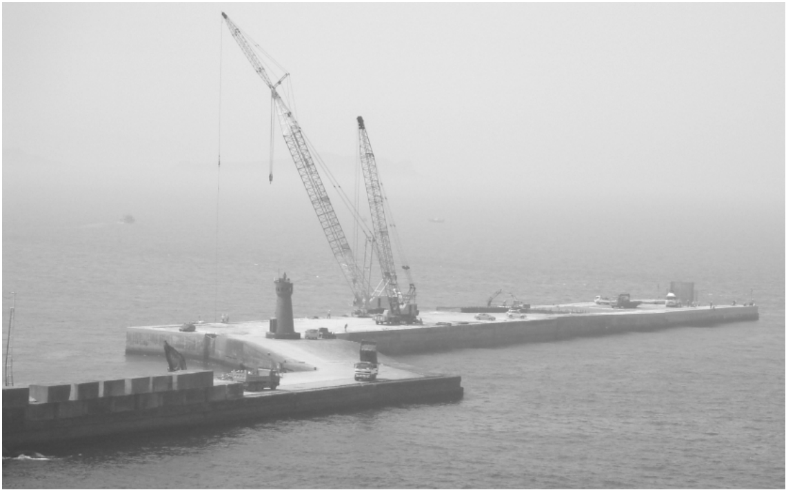
圖 3.4.1 基隆港東防波堤延伸工程施工現況
