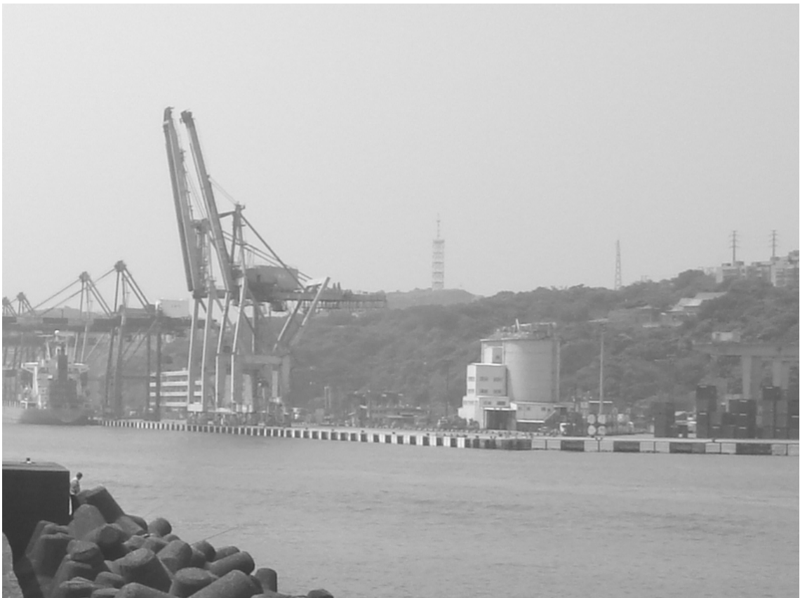
圖 3.4.2 基隆港西 18、19 貨櫃碼頭延建工程完工後現況
