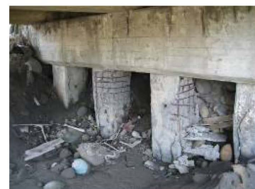
混凝土剝落鋼筋外露(中縣溫仔寮橋)
