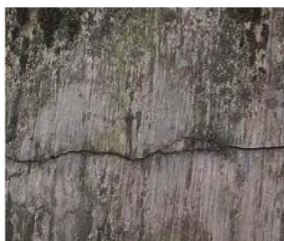
擋土牆破損(北縣黎專橋)
