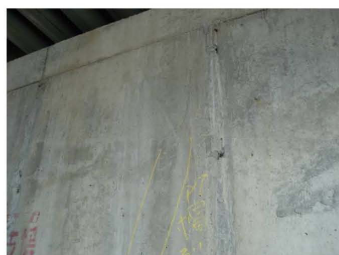
P7帽梁混凝土裂縫
