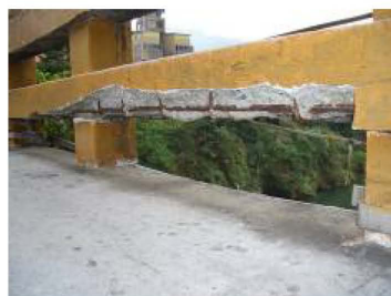
混凝土剝落鋼筋外露(北縣中正橋)
