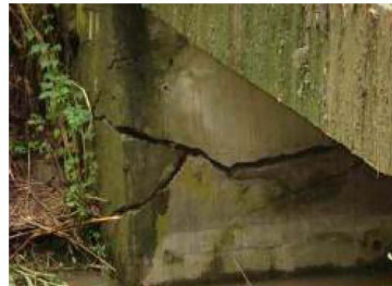
橋台破裂(中市仁德8號橋)
