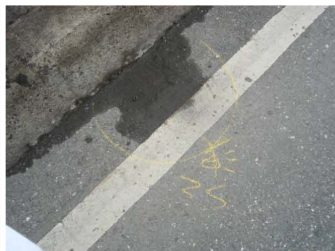
橋面排水孔多處堵塞
