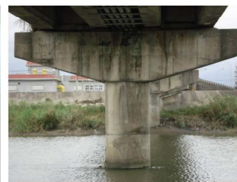
P4墩柱混凝土裂縫
