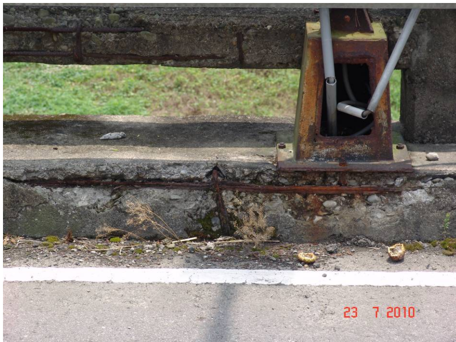
圖 5.11 載熙橋緣石劣化照片
