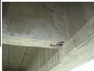
7D3-1隔梁混凝土剝落、鋼筋外露銹蝕
