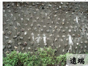
A1、A2橋台兩側擋土牆裂縫
