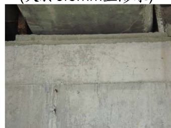
P7帽梁混凝土裂縫
