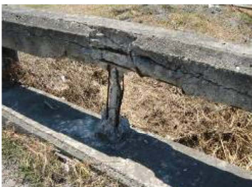
混凝土破碎鋼筋銹蝕(彰縣三和橋)
