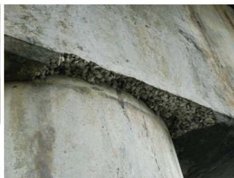
P2帽梁混凝土蜂窩、鋼筋外露
