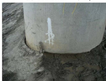
P5河岸堤防保護工與墩柱分離
