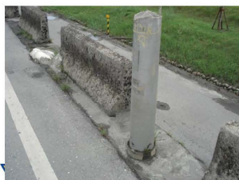
近端引道路燈斷裂
