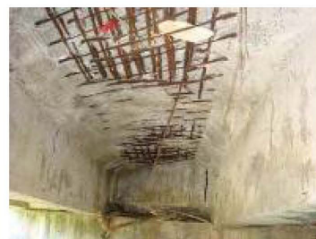
橋鋼筋外露(北縣後寮橋)
