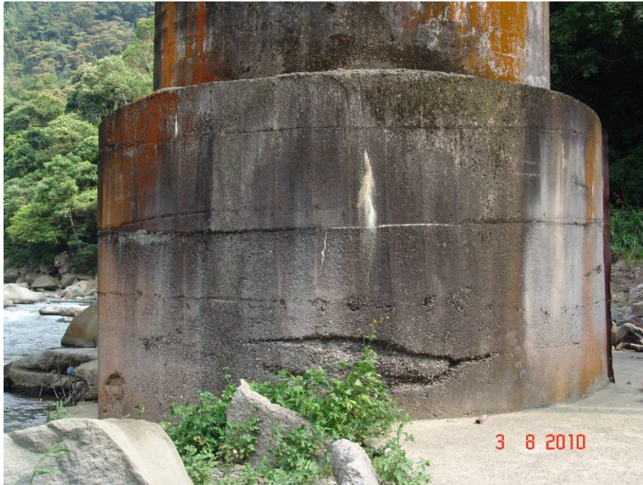
圖 5.24 嘉興大橋橋墩墩體劣化照片
