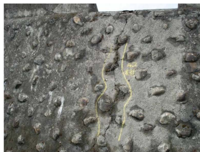
A2橋台兩側擋土牆裂縫
