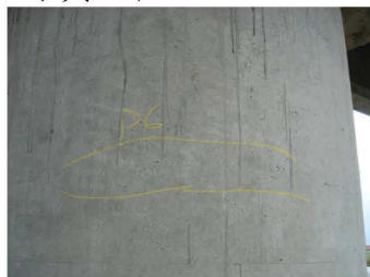
P6橋墩混凝土裂縫
