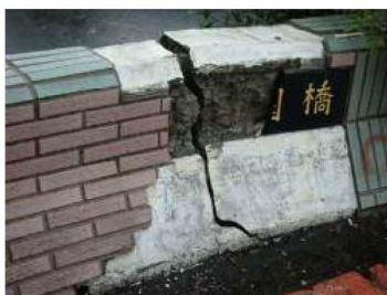
護牆開裂破損(北縣公園橋)
