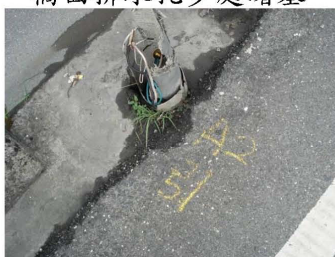
遠端引道路燈斷裂
