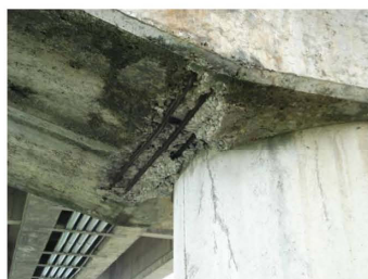
P2帽梁混凝土蜂窩、鋼筋外露銹蝕
