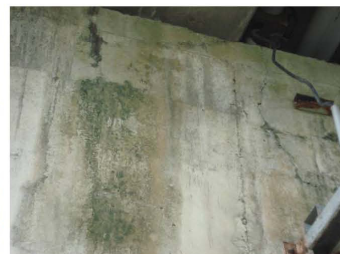
P6帽梁混凝土裂縫 (大於0.3mm且滲水)
