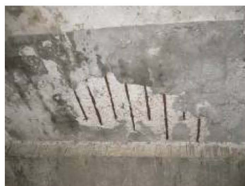
橋鋼筋外露(竹縣振興橋)
