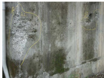
A2橋台混凝土破損
