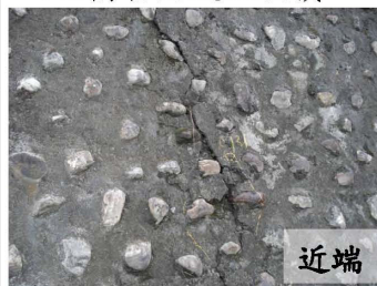
A1、A2橋台兩側擋土牆裂縫
