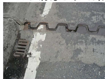
整體性伸縮縫填縫材劣化
