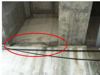
A1處止震塊破裂
