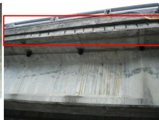
S02橋面板鋼筋外露銹蝕
