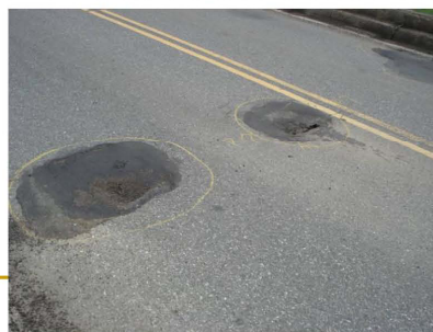
P7橋墩處摩擦層凹陷
