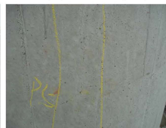
P5墩柱混凝土裂縫
