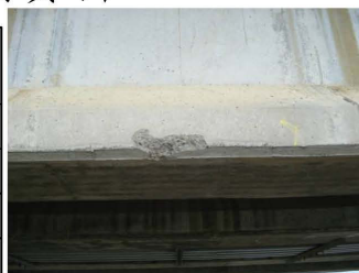
7G1大梁混凝土破損
