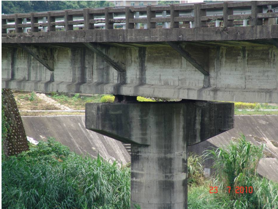
圖 5.18 載熙橋支承形式照片
