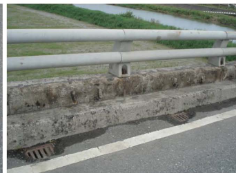
護欄鋼筋外露保護層不足
