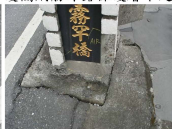
近端橋名牌混凝土剝落
