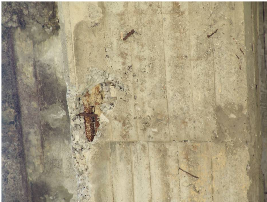
圖 5.23 增昌橋大梁劣化照片
