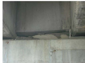
A2止震塊混凝土破裂
