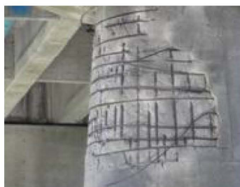
混凝土剝落鋼筋外露(北縣江北大橋)
