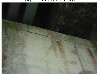
P2帽梁混凝土裂縫
