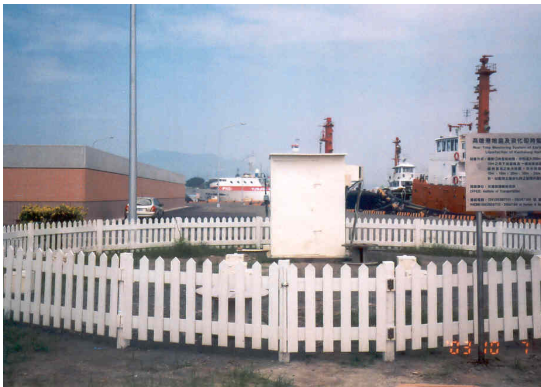
圖 5.7 高雄港區地震分層監測站設置完成外貌狀況
