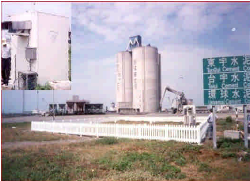
圖 4.7 臺中港區地震分層監測站設置完成外貌狀況
