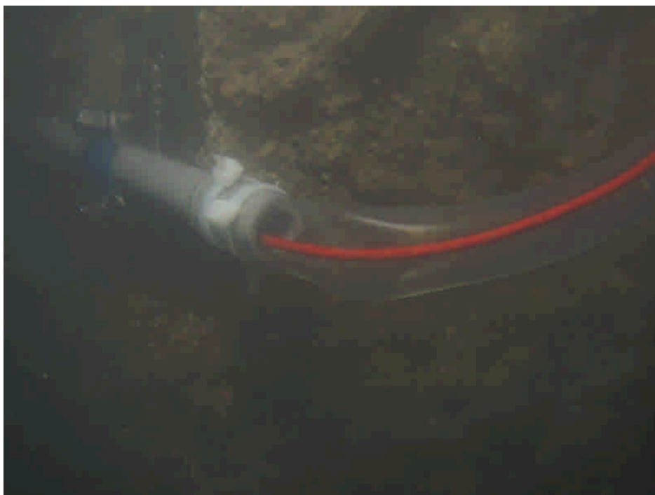
圖 5.4 水下訊號線固定
