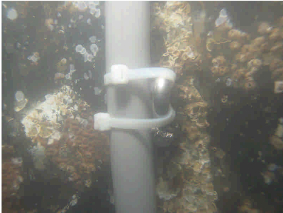
圖 5.3 動態剖面位移計水下安裝完成圖
