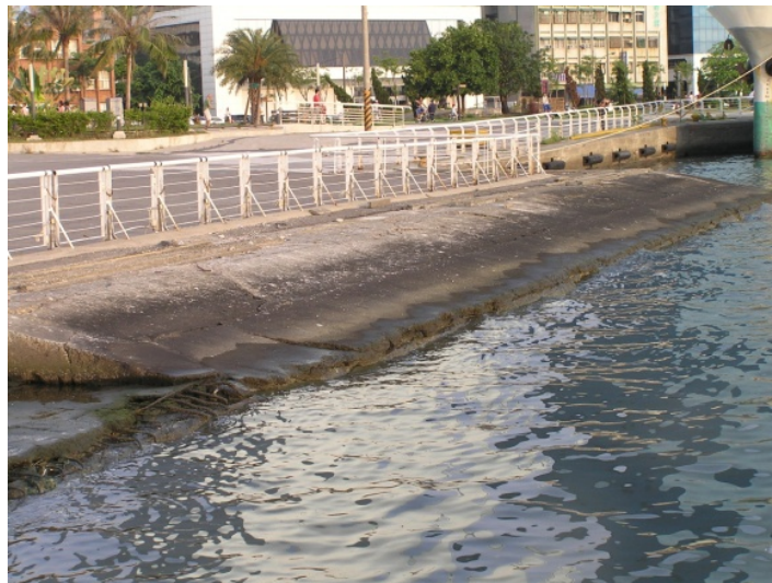
圖 5.45 高雄港真愛碼頭左岸的緩斜坡護岸
