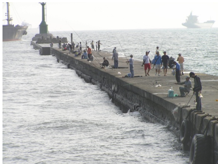
圖 5.35 沉箱防波堤內側海生較多
