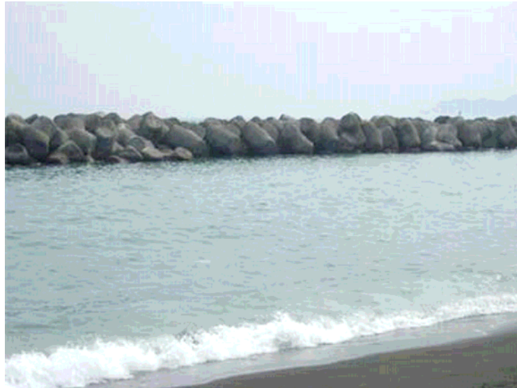
圖 6.35 消波塊形式的離岸堤阻礙了海面的眺望
