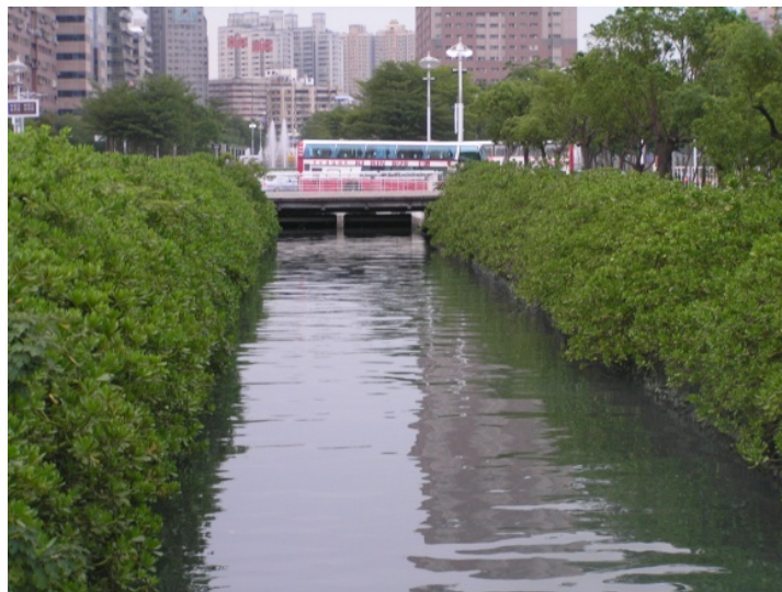
圖 5.47 高雄港新光碼頭護岸的立面植生
