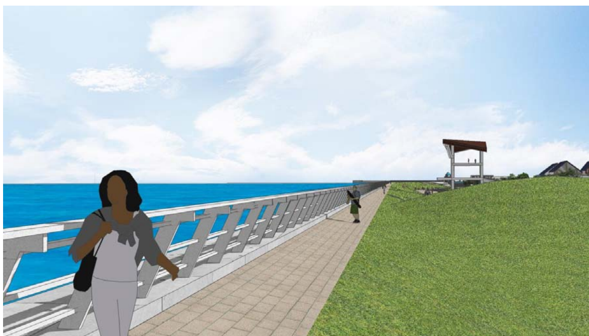
圖 7.31 購物商場區海堤陸側提高覆土
