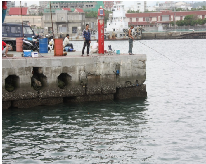
圖 5.38 孔洞型岸壁設計(花蓮港)
