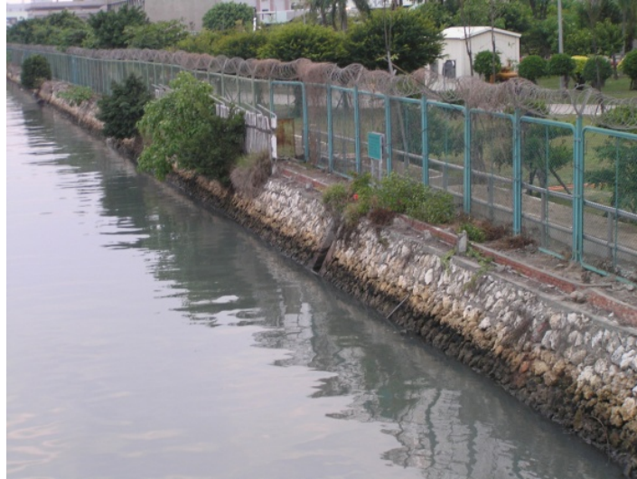
圖 5.46 高雄港第五船渠之泥漿石砌護岸
