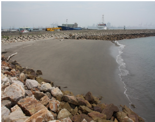
圖 5.12 消波塊與石塊所組成之 保護工
