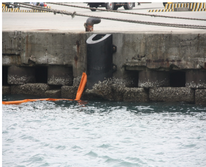
圖 5.41 置放鋼製受衝板的碰船墊 a
