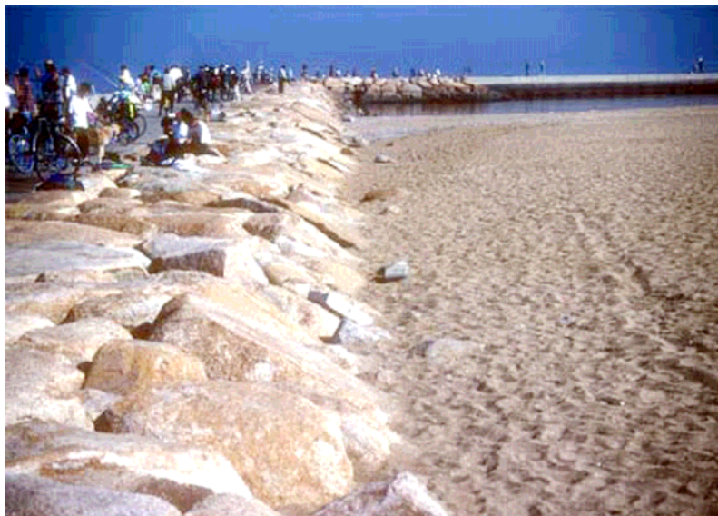
圖 6.42 與沙灘滑順收斂的堆石突堤
