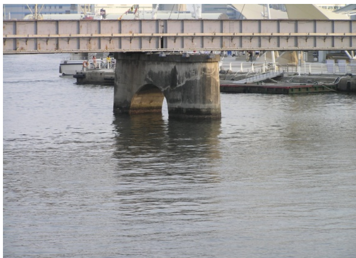
圖 5.50 高雄愛河口之橋墩
