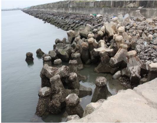
圖 5.16 臺北港區內消波塊(一)
