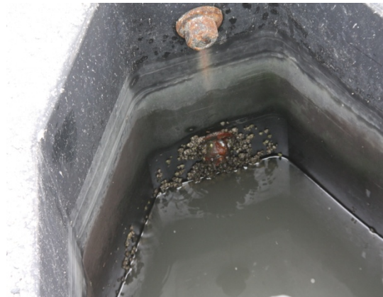
圖 5.26 水質髒亂之防舷材內部(一) 圖 5.27 水質髒亂之防舷材內部(二)
