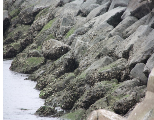
圖 5.22 臺北港區內之拋石護岸(三) 圖 5.23 臺北港區內之拋石護岸(四)
