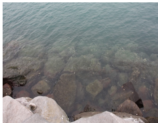
圖 5.21 臺北港區內之拋石護岸(二)
