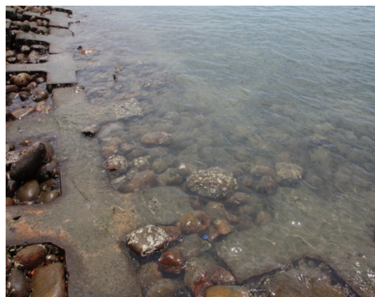
圖 5.5 臺中港緩坡護岸(二)
