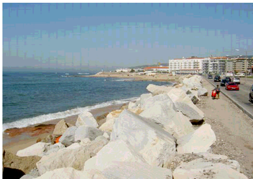
圖 6.31 自然石堆積的護岸 b
