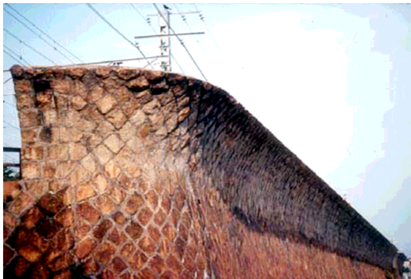
圖 6.27 回波工程形狀的海堤
