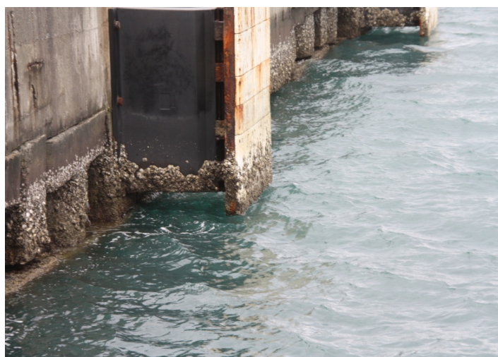
圖 5.42 置放鋼製受衝板的碰船墊 b
