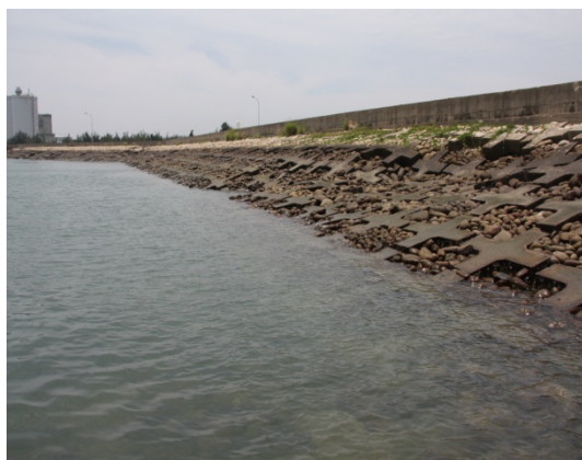
圖 5.4 臺中港緩坡護岸(一)
