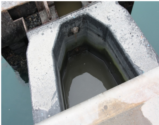
圖 5.26 水質髒亂之防舷材內部(一) 圖 5.27 水質髒亂之防舷材內部(二)
