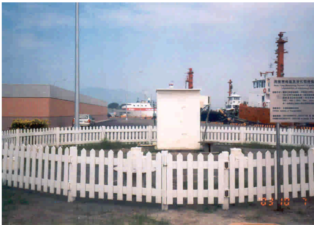
圖 8.7 高雄港區地震分層監測站設置完成外貌狀況
