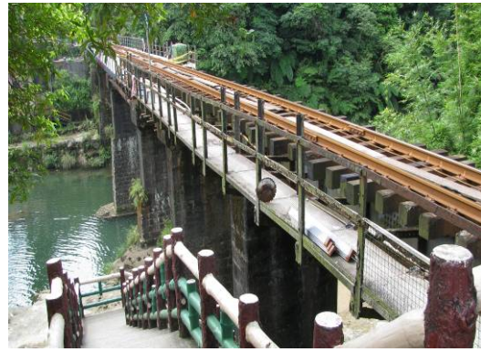
D=2；鋼製人行道板油漆剝落、輕微生銹 E=3；損傷範圍已達 30% R=1；尚不影響結構之完整性及作業人員安全
