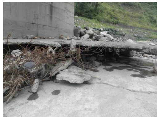
D=4：護床工嚴重沈陷，造成混凝土碎裂、鋼筋斷裂 E=4：損壞範圍遍及整體橋下河道護床工 R=3：大部分保護設施損壞，洪水來臨時恐造成嚴重的淘刷，影響結構安全
