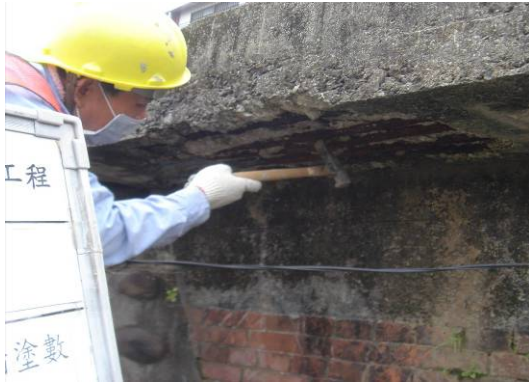
D=3；人行道板混凝土剝落、鋼筋局部外露銹蝕 E=2；局部剝落，應視現場劣化比例 R=1；尚不影響結構之完整性及作業人員安全
