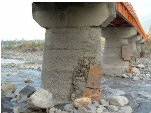
D=4：橋墩防撞鋼板沖毀、脫落、遺失 E=4：損壞範圍遍及所有橋墩 R=3：橋墩混凝土碎裂、鋼筋裸露斷裂，已影響下部結構安全
