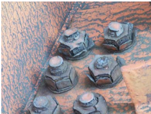
D=3；隔梁與大梁接合板處螺栓嚴重銹蝕劣化 E=3；視損劣化數量佔該跨總數之比例 R=2；螺栓可能已嚴重受損，應儘速替換，但劣化部位為次要構件，暫不影響結構安全
