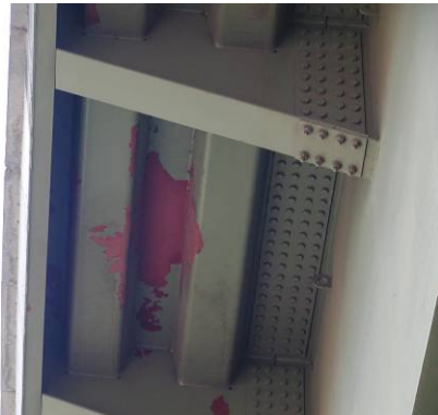
D=2；懸臂處鋼床板油漆局部剝落 E=1；局部剝落 R=1；塗裝油漆雖剝落，仍保有鋼板底漆，無腐蝕現象
