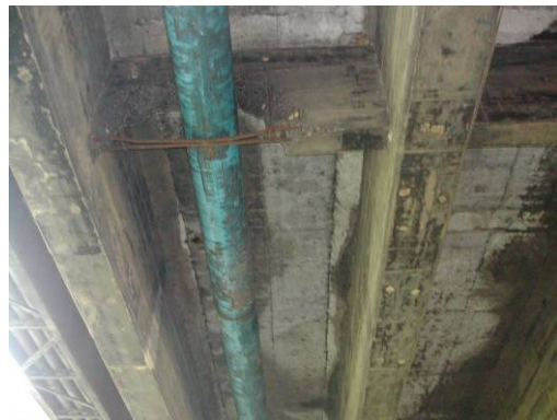
D=4：因事後附掛管線、施工不當，造成橫隔梁嚴重破損 E=2：視全跨中破損橫隔梁之比例 R=2：造成單側結構上的弱面，稍微影響結構之完整性，但無立即之危險
