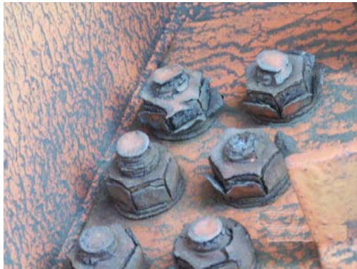
隔梁螺栓嚴重銹蝕、劣化
