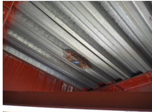
D=3；鋼浪板洩水孔周圍嚴重腐蝕 E=1；局部腐蝕 R=2；構件腐蝕深度未滿板厚 10%，大梁因漏水、滲水已有白華及點狀銹蝕現象
