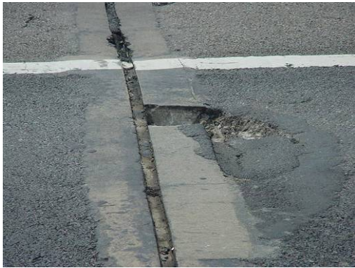
D=3：伸縮縫周圍混凝土及鋪面破損、坑洞 E=2：局部混凝土破損 R=2：已影響行車舒適度，若為機車道則可能影響機車及自行車之行車安全
