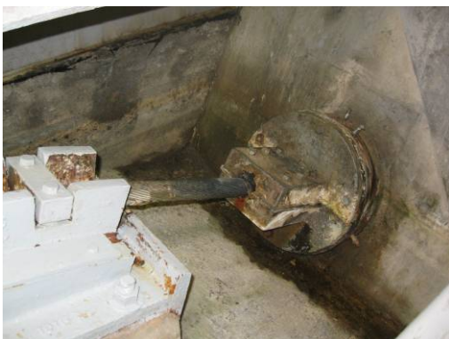
D=2；錨碇座位置有滲水、積水情形 E=2；應視其佔所定範圍內之比例 R=2；避免錨碇處滲水導致鋼纜銹蝕，應進一步檢測，確保鋼纜之狀況，且應修復排水系統
