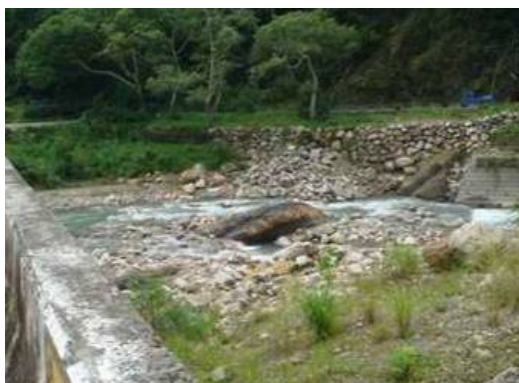
照片 4.4 引道護坡淘刷沈陷
