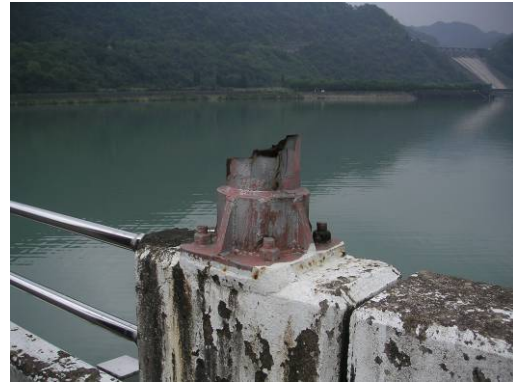
D=4：照明設備斷裂 E=2：視損壞燈柱佔總數之比例 R=2：雖對行車安全無立即性危險，但對夜間駕駛可能造成影響，應儘速維修
