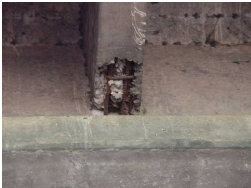
D=3：混凝土蜂窩、鋼筋部分外露且有銹蝕現象 E=1：小範圍劣化 R=1：尚不影響結構安全
