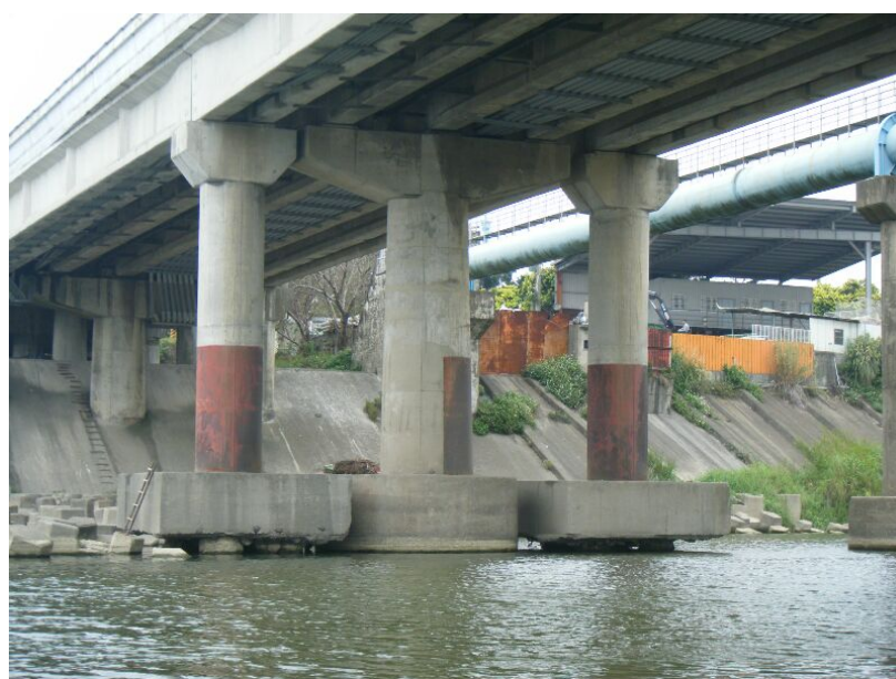
圖 2.9 二代橋結構型式(苗栗縣東興橋)
