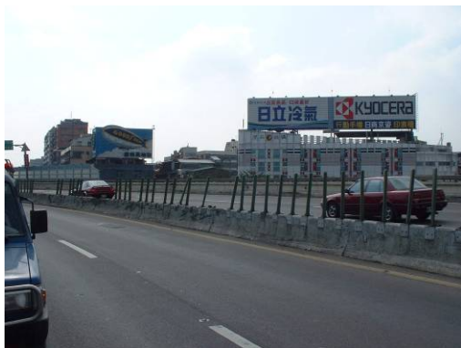
D=3：防眩設施歪斜、脫落 E=3：劣化範圍超過 30% R=3：構件歪斜、突出、可能危及行車安全
