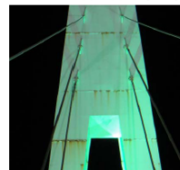
照片 4-58 橋塔接縫處生銹
