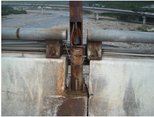
D=3：大範圍生鏽，且有局部腐蝕 E=3：視劣化燈柱佔總數之比例 R=1：尚不影響交通安全
