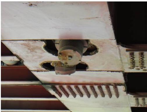
D=2；錨頭局部生銹 E=2；局部劣化 R=1；局部生銹，尚不影響結構安全
