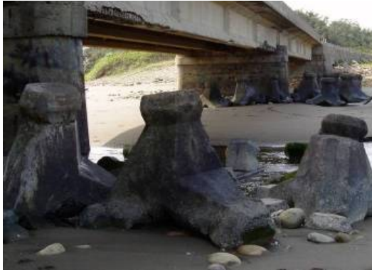
D=3：局部鼎型塊遭洪水破壞、移位、沖失 E=2：視劣化範圍及沖失數量而定 R=2：尚不影響結構安全
