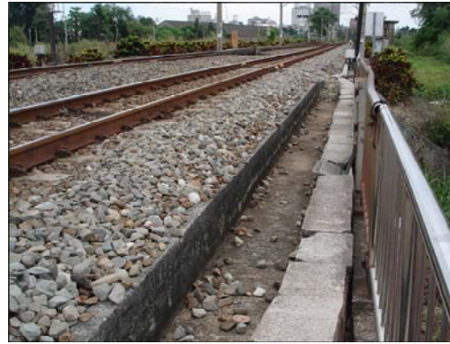
D=2；電纜槽蓋混凝土破損、移位 E=2；局部劣化 R=1；尚不影響作業人員安全
