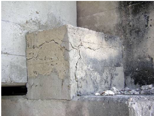
D=3：混凝土裂縫寬度介於 0.3mm~0.6mm E=1：局部止震塊劣化 R=2：尚不影響結構安全及其功能性
