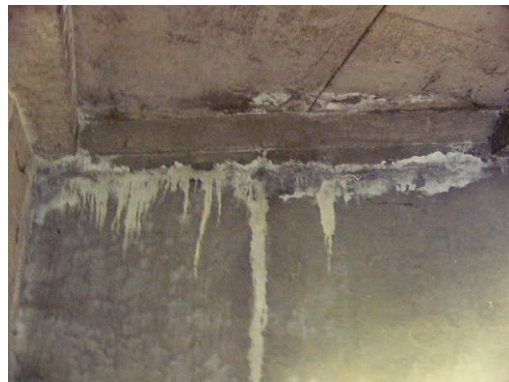
D=3：橫隔梁與橋面板銜接處白華且有銹水 E=2：視全跨中橫隔梁劣化之比例 R=2：尚不影響結構安全，但須觀察滲水之原因是否為橋面板上之損傷所造成
