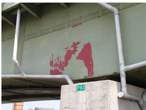
D=2；油漆剝落佔整體構件面積 10%以下 E=1；局部剝落 R=1；構件表面尚未銹蝕，尚不影響結構安全
