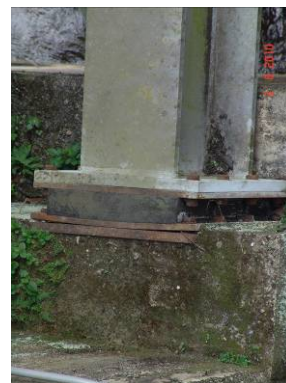
D=3；橋墩基底承壓鋼板翹曲變形與底板產生間隙，且鋼板與錨碇螺栓有腐蝕現象 E=1；局部劣化 R=3；因劣化位置位於橋墩基底，屬影響結構安全之主構件，應儘速修復
