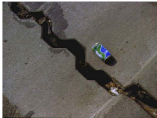
照片 4.28 伸縮縫填縫膠損壞
