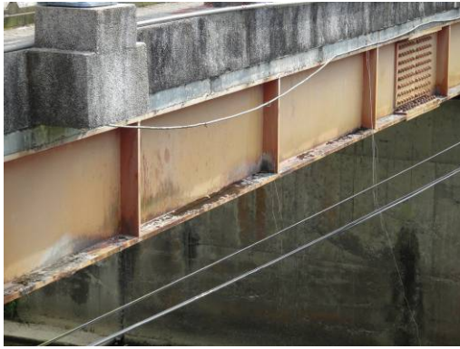
D=3；大梁下翼板側油漆變色、白華化，且已有局部翼板已經銹蝕 E=3；劣化範圍已達 30%以上 R=3；劣化面積較大，且有鋼板銹蝕現象
