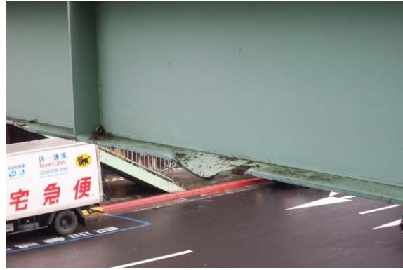
D=3；下翼板有明顯之局部變形 E=1；局部損壞 R=2；主構件有明顯之局部變形，對結構安全稍有影響，但無立即之危險
