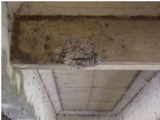
D=2：橫隔梁混凝土剝落、部分鋼筋外露但無腐蝕現象 E=1：局部橫隔梁劣化 R=1：混凝土局部脫落、尚不影響結構安全
