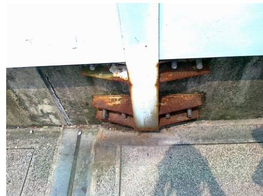
D=2：錨碇處構件生鏽 E=2：視劣化範圍佔整體之比例 R=1：尚不影響用路人安全
