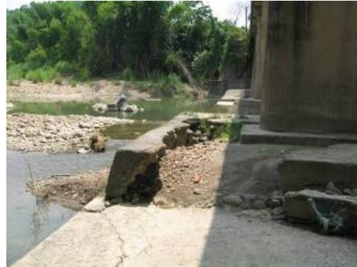
D=3：混凝土保護設施局部損毀 E=2：局部範圍損壞 R=2：尚不影響結構安全
