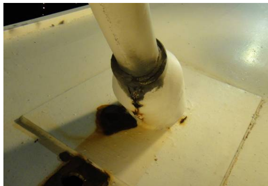
D=3；錨碇裝置油漆龜裂、剝落、局部銹蝕 E=2；視劣化數量佔橋跨錨碇裝置總數比例 R=3；因雨水順沿鋼纜流下，恐有滲漏至內部鋼纜的情形，目前錨碇處表面已有銹蝕現象
