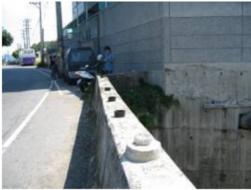
D=4：反光標誌斷裂、脫落 E=4：全部反光標誌損壞 R=2：雖對行車安全無立即性危險，但對夜間駕駛可能造成影響，應儘速維修
