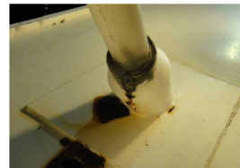
照片 4-60 大梁端錨碇裝置銹蝕
