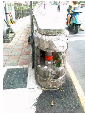
D=2：因事故撞擊，橋名護欄玻璃製品破損 E=2：局部範圍損壞 R=1：尚不影響交通安全，若內部照明有損壞，可能影響夜間行車安全，則需斟酌提高評估值
