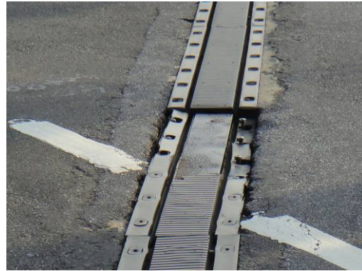
D=4：部分橡膠材破損及錨碇螺栓脫落、凸起 E=2：局部範圍損壞 R=4：凸起之螺栓恐造成行車事故，威脅用路人之安全，應儘速修復
