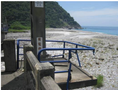
D=4；避車台金屬欄杆銹蝕、斷裂 E=3；近半之構件已損壞斷裂 R=4；雖無結構安全問題，但欄杆斷裂恐造成夜間避車人員墜落之可能性。
