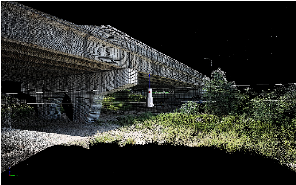
圖 2.19 大甲溪橋地面雷射掃瞄
