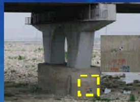
橋墩監測點佈設
