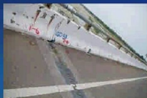
橋版面監測點佈設
