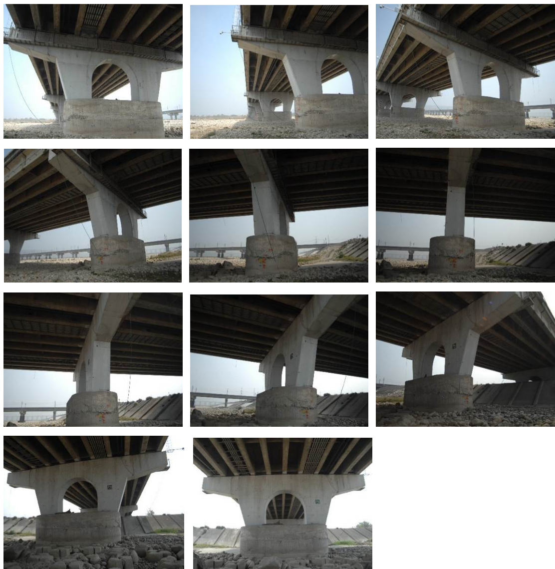
圖 4.10 29 號橋墩近景環場攝影照片與控制點分布圖
