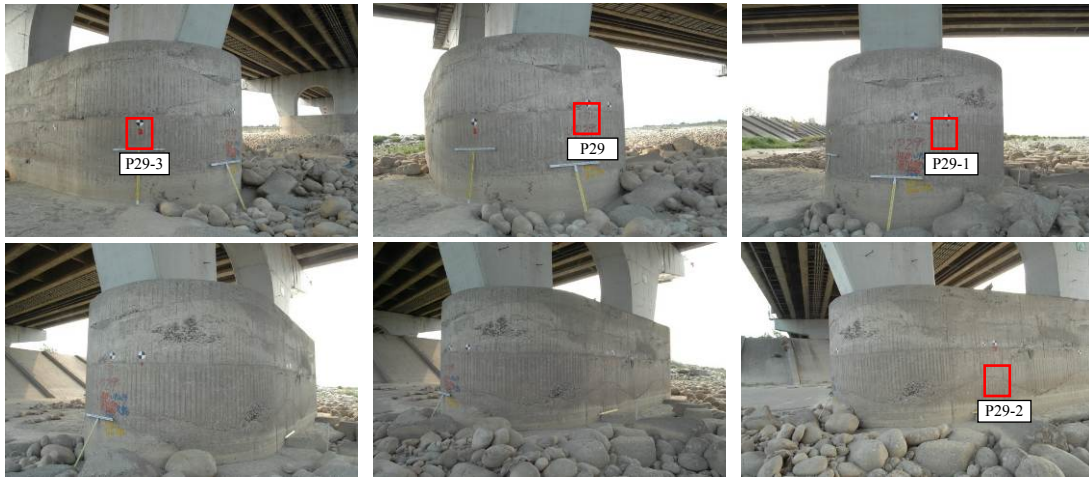
圖 4.12 第二次拍攝照片與控制點分布圖
