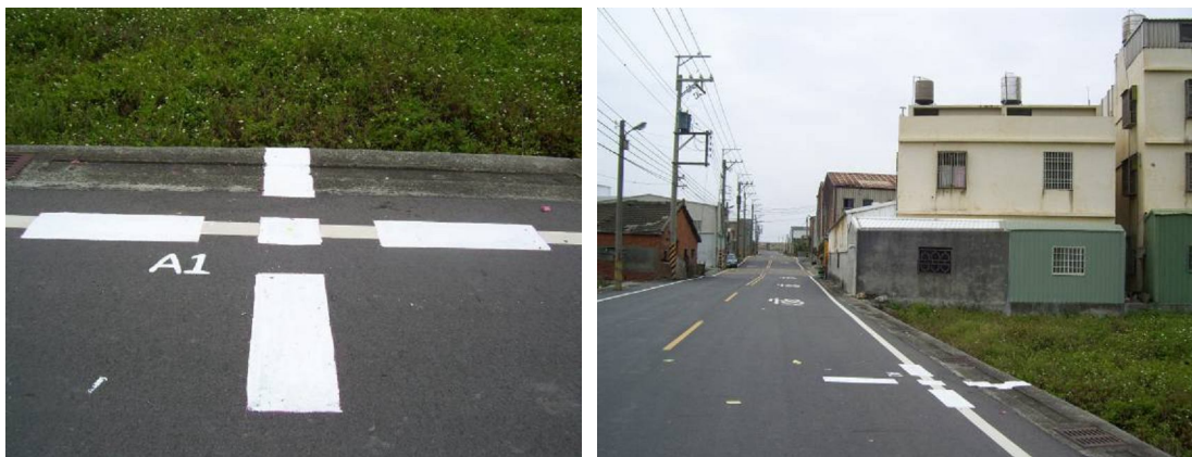
圖 2.2 航空標現場照片
