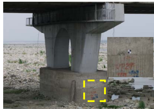
圖 4.2 橋墩監測點佈設
