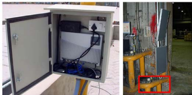
圖 6-24 讀取器與 RFID 天線安裝示意
