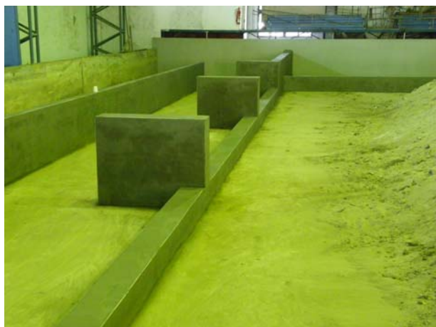
照片8.6 尾水路磚牆製作
