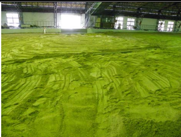
照片8.15 模型用砂鋪設
