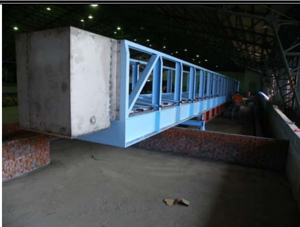
照片8.9 傾動水槽組裝作業
