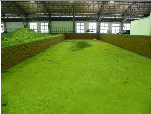
照片8.3 整流槽四周磚牆製作
