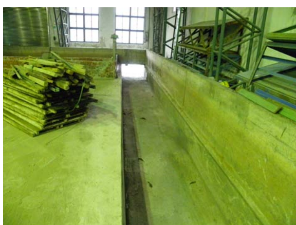
照片8.12 尾水回水溝完工
