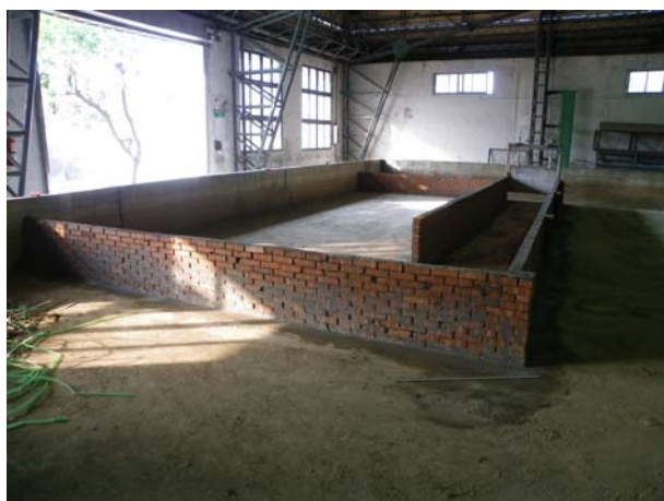
照片8.8 傾動水槽率定用沉砂池製作
