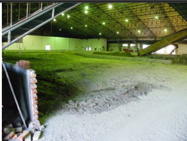
照片8.10 水工模型底座砂石填充作業
