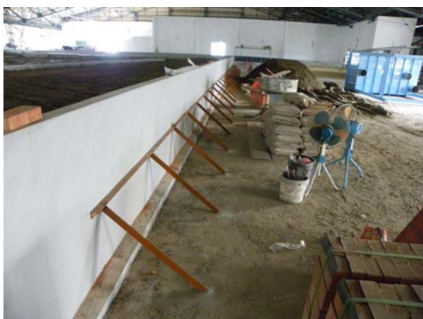
照片8.11 西側磚牆補強作業
