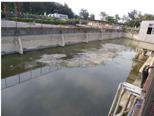
照片8.13 蓄水池清理作業
