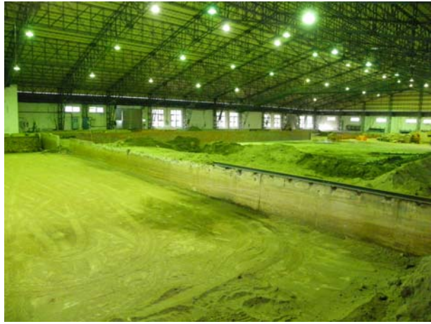
照片8.2 既有設備移除
