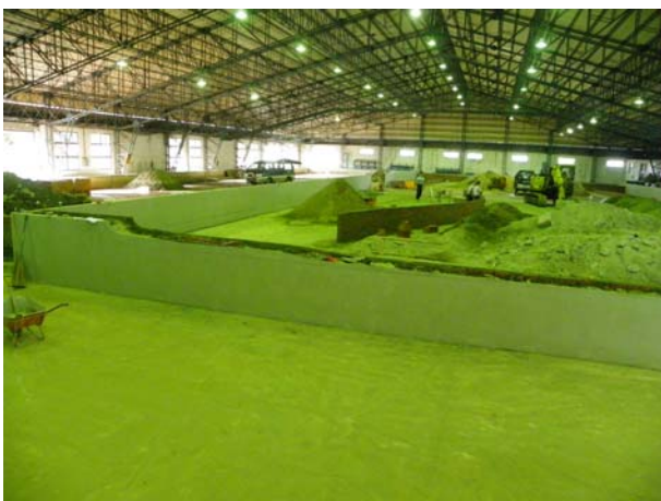
照片8.5 水工模型漸變段定床製作及 河道護岸磚牆製作
