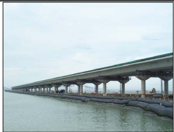
照片2.2 韓國仁川跨海大橋橋墩保護應用案例(砂腸管)
