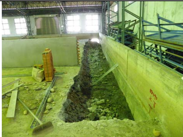
照片8.4 尾水回水溝開挖作業
