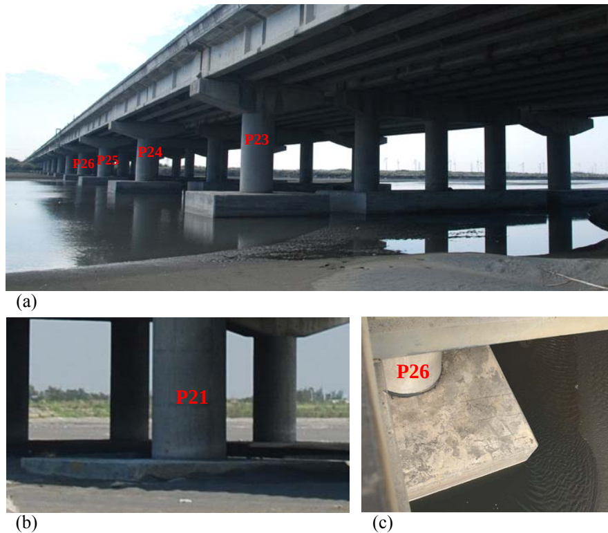
圖6.8 西濱大橋施測時情況 (a)P23 以南(b) P21 基礎(c) P26 基礎
