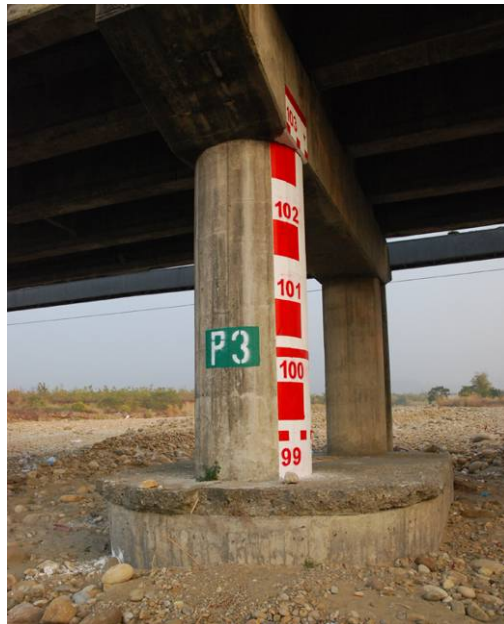
圖5.9 標竿水尺示意圖（臺3線興昌橋）
