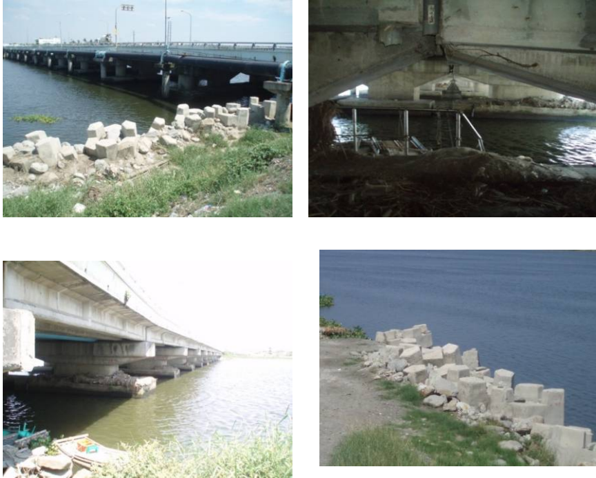
圖4.10 東港大橋之現地照片
