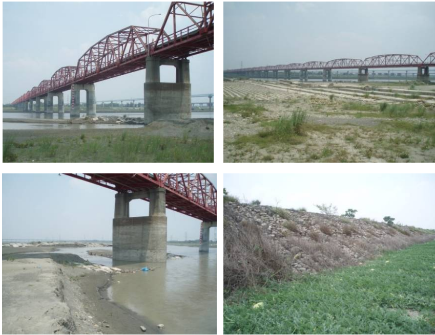
圖4.17 西螺大橋之現地照片
