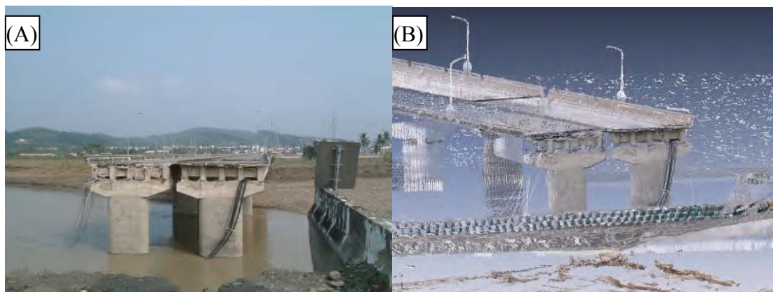
圖5.32 新旗尾橋災後照及 3D LIDAR 掃描圖
