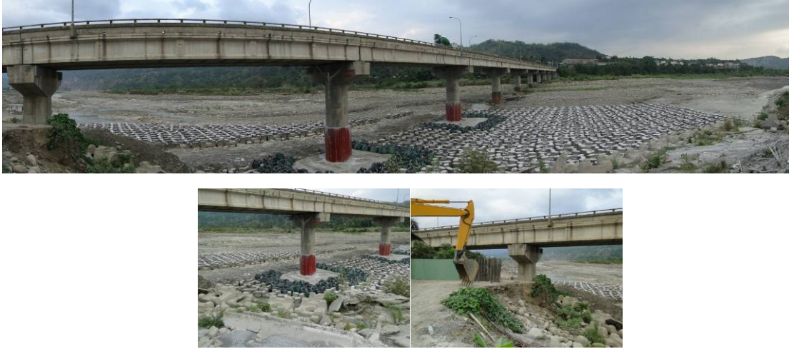
圖4.13 寶隆大橋之現地照片
