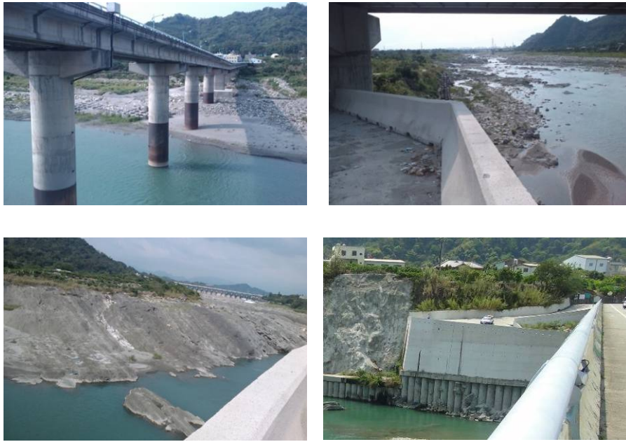
圖4.15 埤豐橋之現地照片
