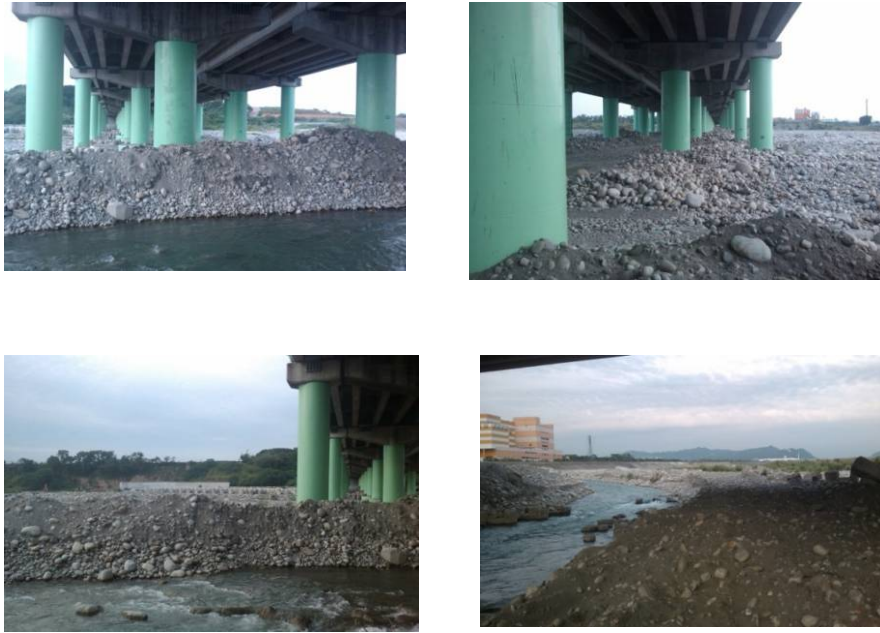
圖4.6 大甲溪國道一號橋之現地照片
