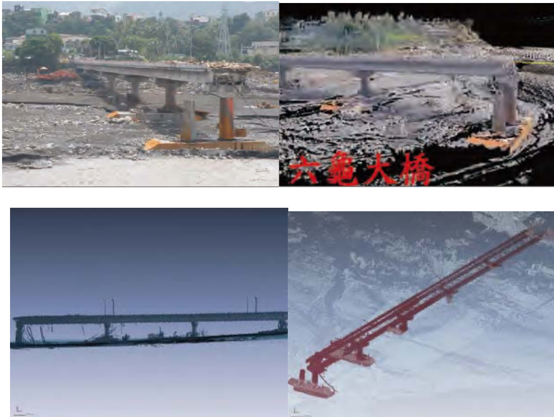
圖5.31 六龜大橋災後照及 3D LIDAR 掃描圖
