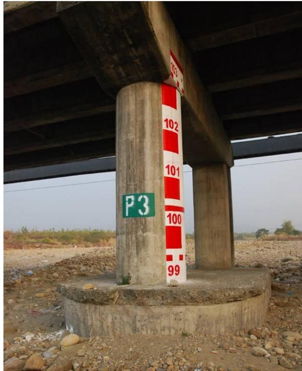
圖C5.4.1 標竿水尺示意圖（台3線興昌橋）
