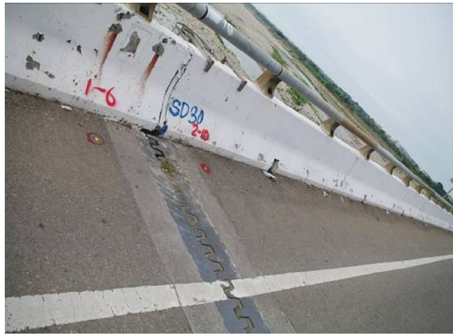
圖 2.6 橋面板監測點佈設
