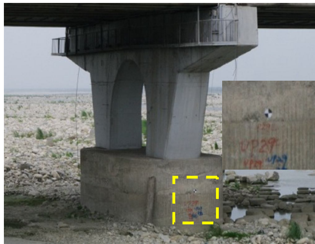
圖 2.8 橋墩監測點佈設
