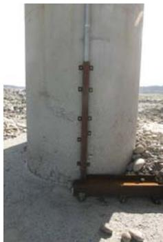
圖 7.19 國道 3 號大甲溪橋 P24 橋墩監測儀器
