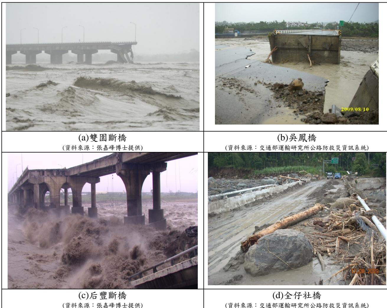
**圖 3.1 橋梁損害照片**
