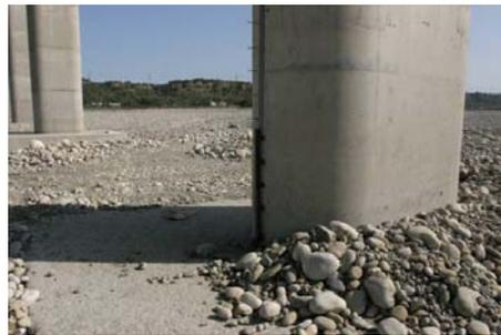
圖 7.18 國道 3 號大甲溪橋 P21 橋墩監測儀器
