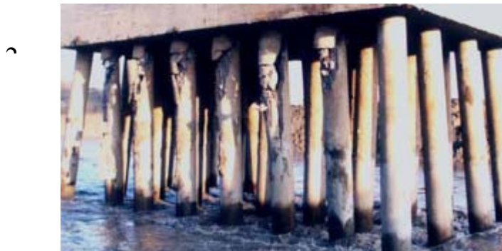
圖 1.2 橋墩衝擊磨耗破壞之情形 [3]
