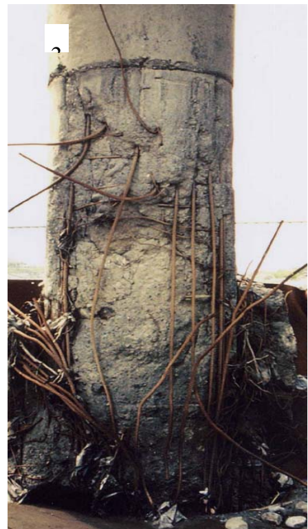
圖 1.2 橋墩衝擊磨耗破壞之情形 [3]
