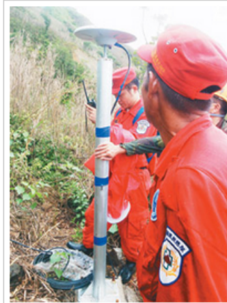
蘇花公路115.9公里處，邊坡大面積崩塌處上方，設置有5支坡面位移監測器，隨時掌控下方用路人經過安全。 記者簡榮輝／攝影
