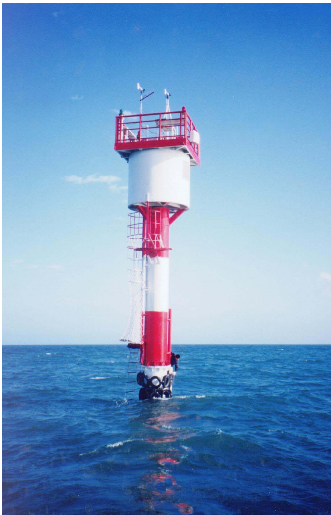
照片 1.2 臺北港觀測樁
