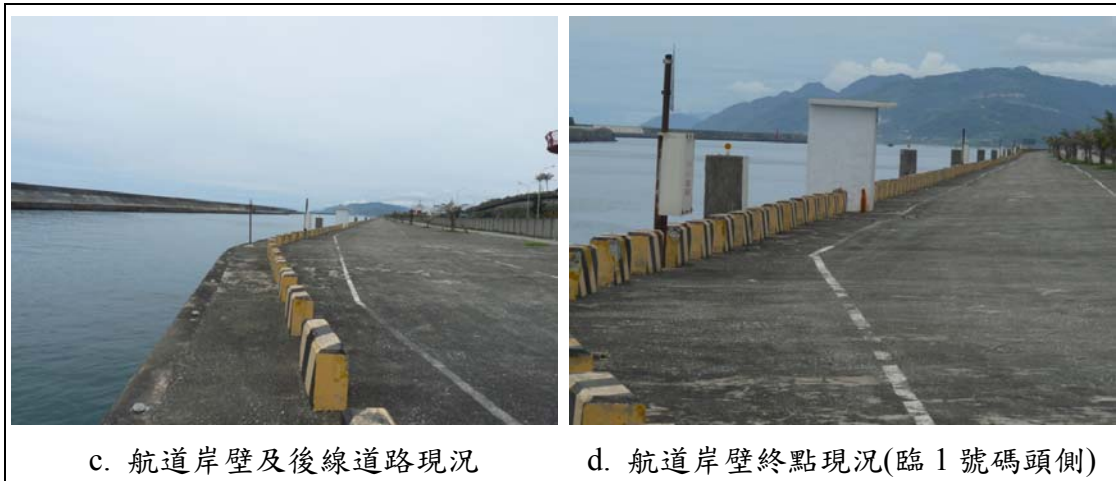
圖 39 花蓮港航道岸壁現況情形
