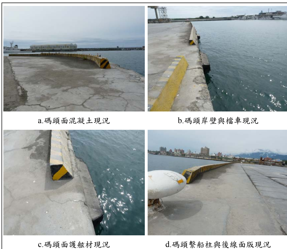
圖 37 花蓮港 9 號碼頭現況情形
