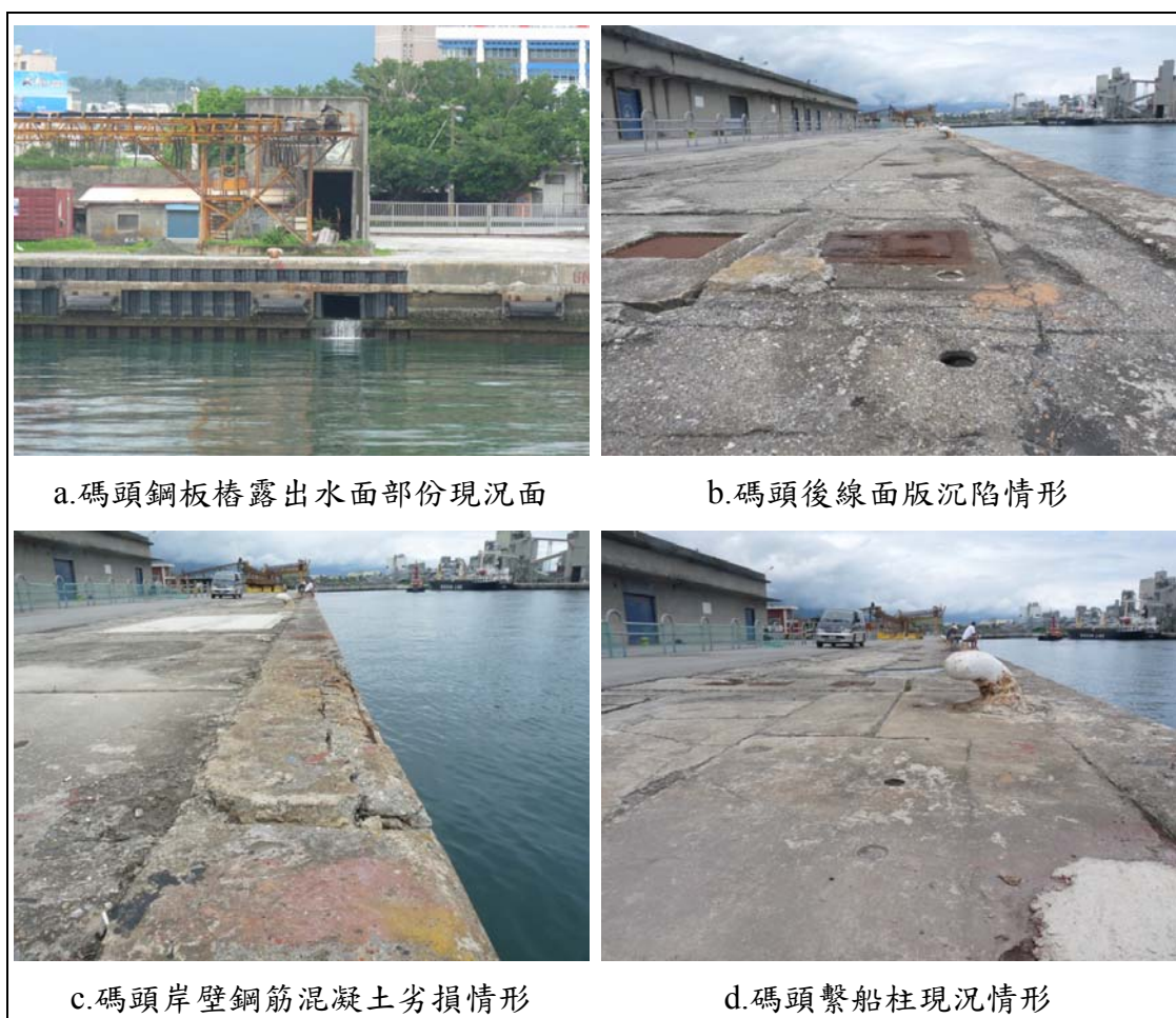
圖 30 花蓮港 5 號碼頭現況情形
