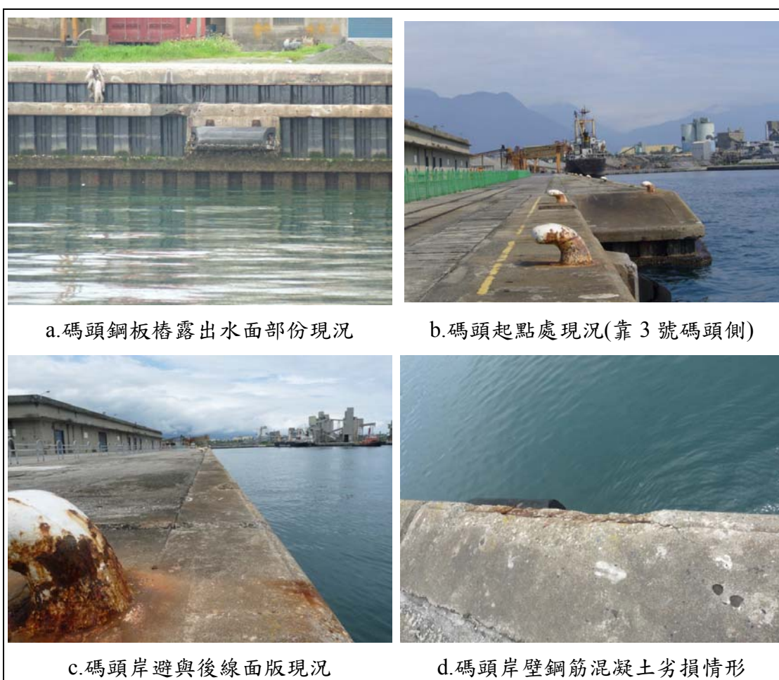
圖 29 花蓮港 4 號碼頭現況情形
