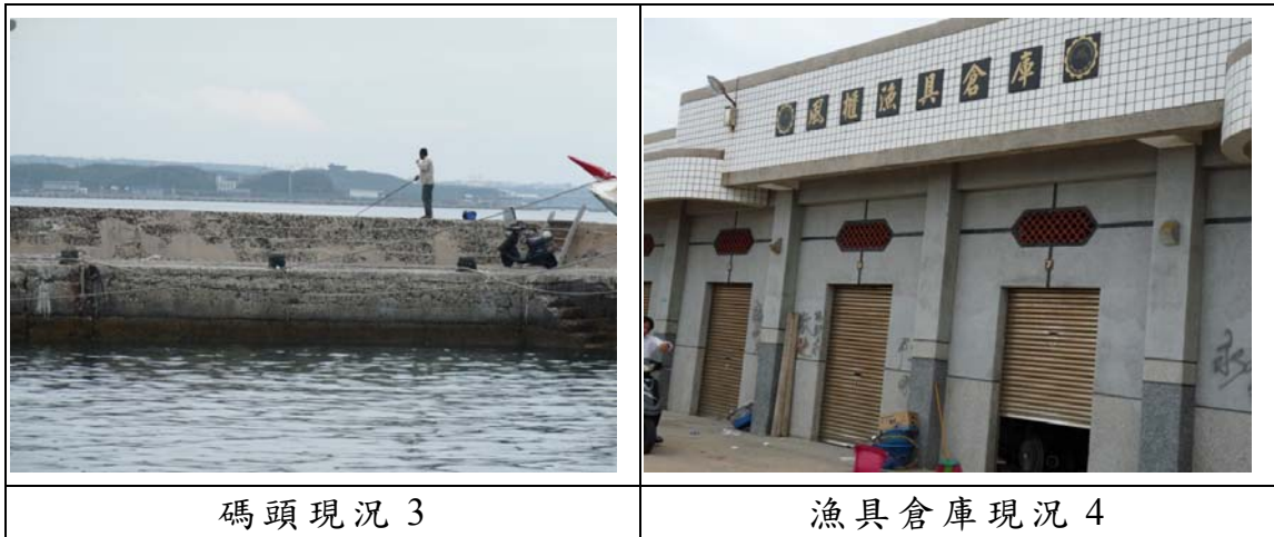
圖 70 風櫃東漁港現況情形（100.6.23）
