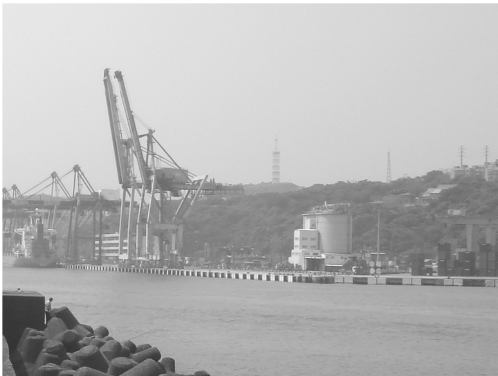
圖 5.2 基隆港西 18、19 貨櫃碼頭延建工程完工後現況
