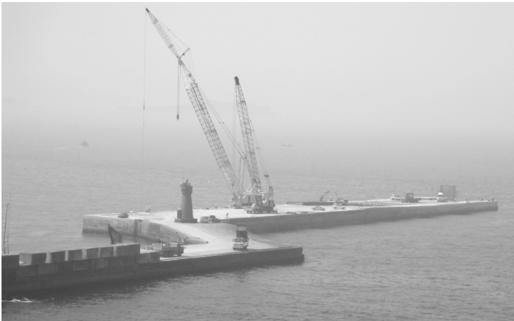
圖 5.1 基隆港東防波堤延伸工程施工現況
