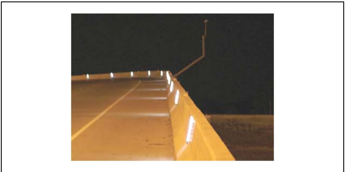
圖 4-36 IPM 安裝於橫向轉彎地帶(Texarkana, Texas)
