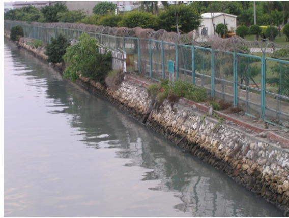
圖 4.17 第五船渠 泥漿石砌護岸
