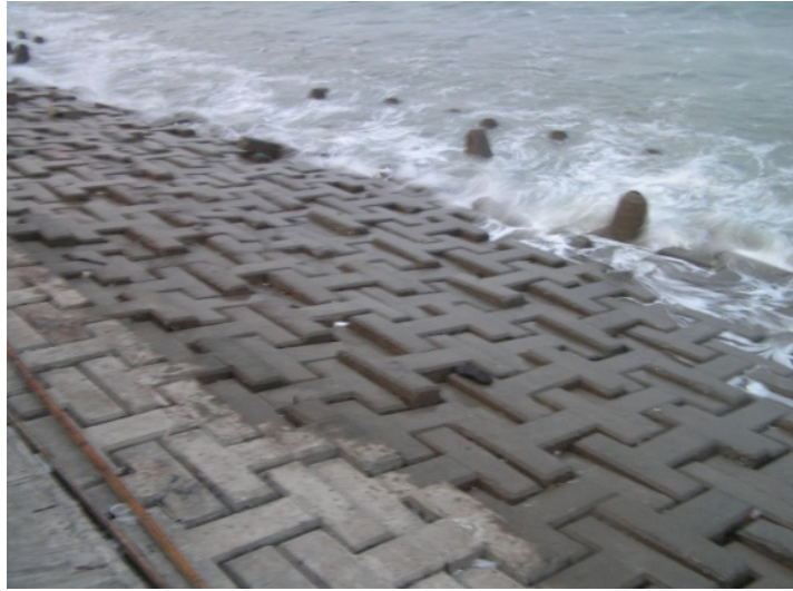
圖 4.22 旗津海岸護坡
