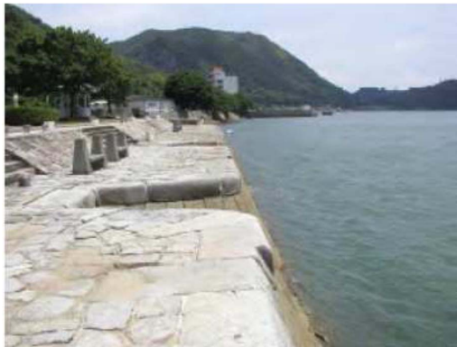
圖 5.28 港灣設施綠化
