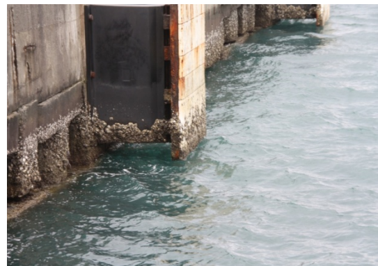
圖 4.12 置放鋼製受衝板的防舷材 圖 4.13 置放鋼製受衝板的防舷材
