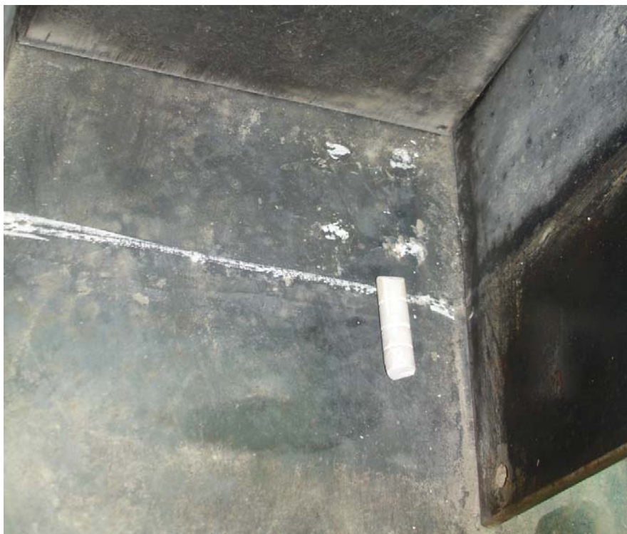
圖 5.11 以粉筆在底板上標記鋼筋位置
