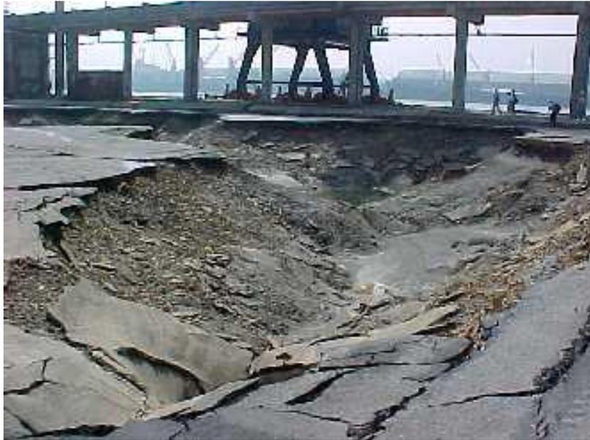
圖 1.4 集集地震臺中港土壤液化引起破壞
