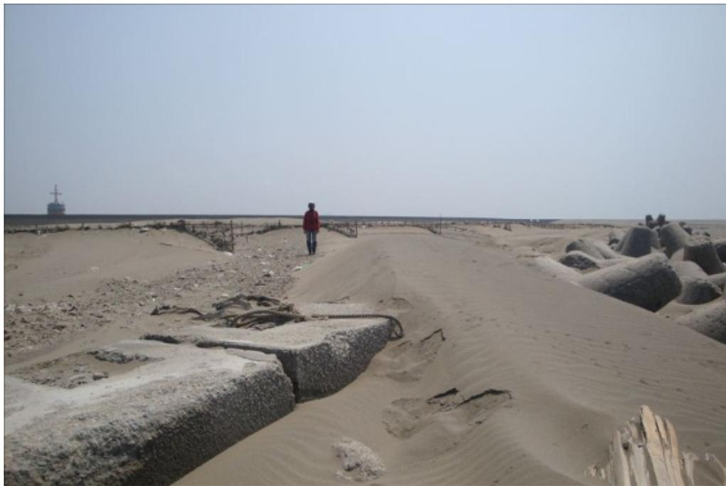
照片 2-3a 臺中港北防波堤位置 2 飛沙淤積圖 (2011/05)
