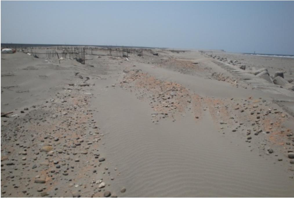
照片 2-3b 臺中港北防波堤位置 2 飛沙淤積圖 (2011/05)
