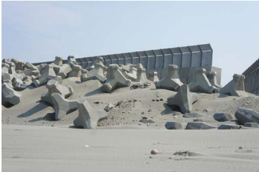
照片 6-13 第三期工程於二期圍堤堤頂處設置長防風柵欄 (2011/10)
