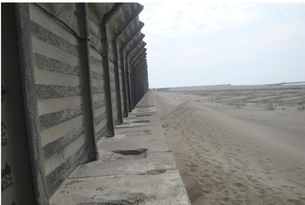
照片 2-6 臺中港北防波堤位置 5 飛沙淤積圖 (2011/05)
