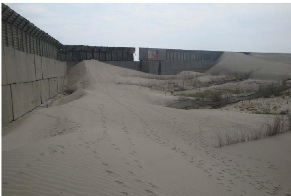
照片 2-7 臺中港北防波堤位置 6 飛沙淤積圖 (2011/05)
