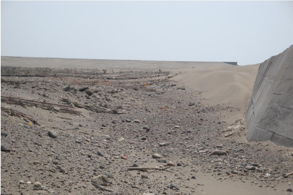
照片 2-8 臺中港北防波堤位置 7 飛沙淤積圖 (2011/05)
