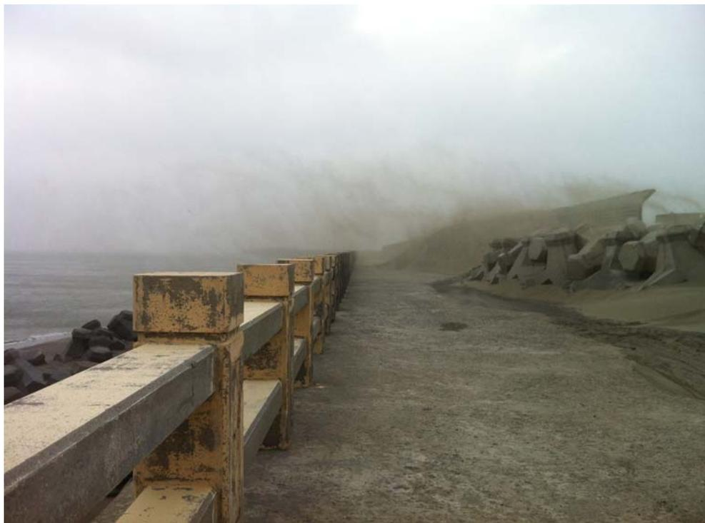
照片 6-18 第三期工程北防波堤堤址處淤沙 (2011/12)
