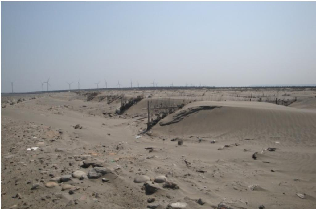
照片 2-3c 臺中港北防波堤位置 2 飛沙淤積圖 (2011/05)
