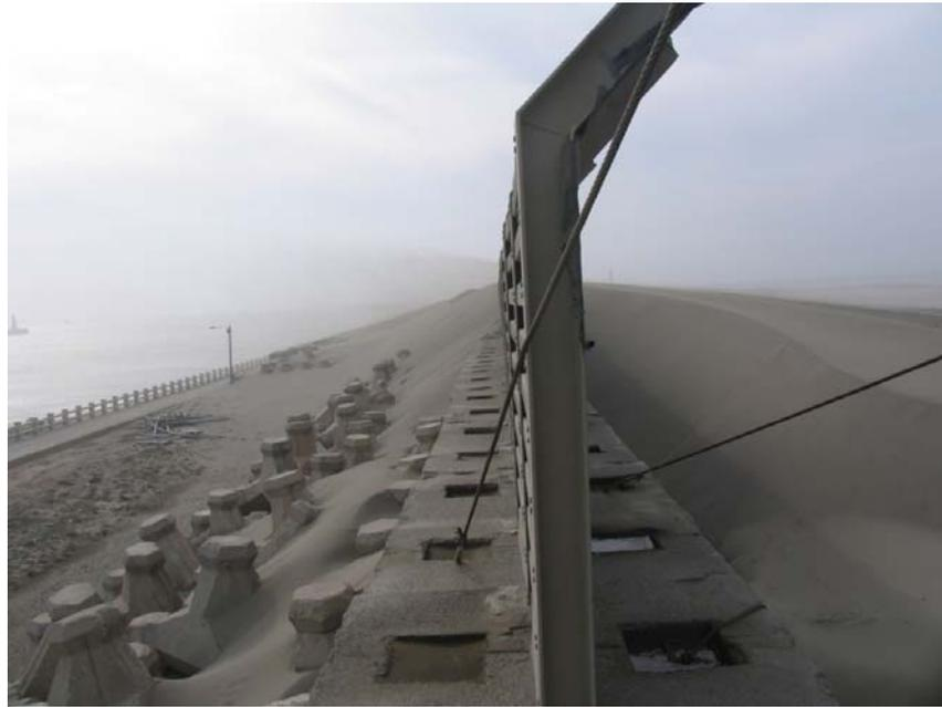
照片 2-10 臺中港北防波堤位置 9 飛沙淤積圖 (2011/05)
