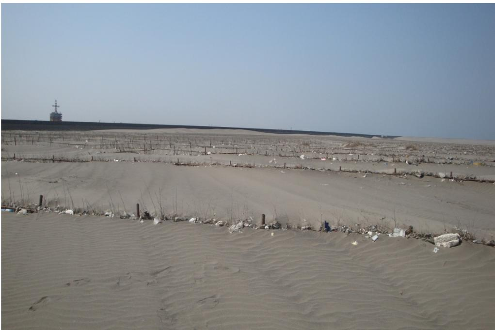
照片 2-4 臺中港北防波堤位置 3 飛沙淤積圖 (2011/05)
