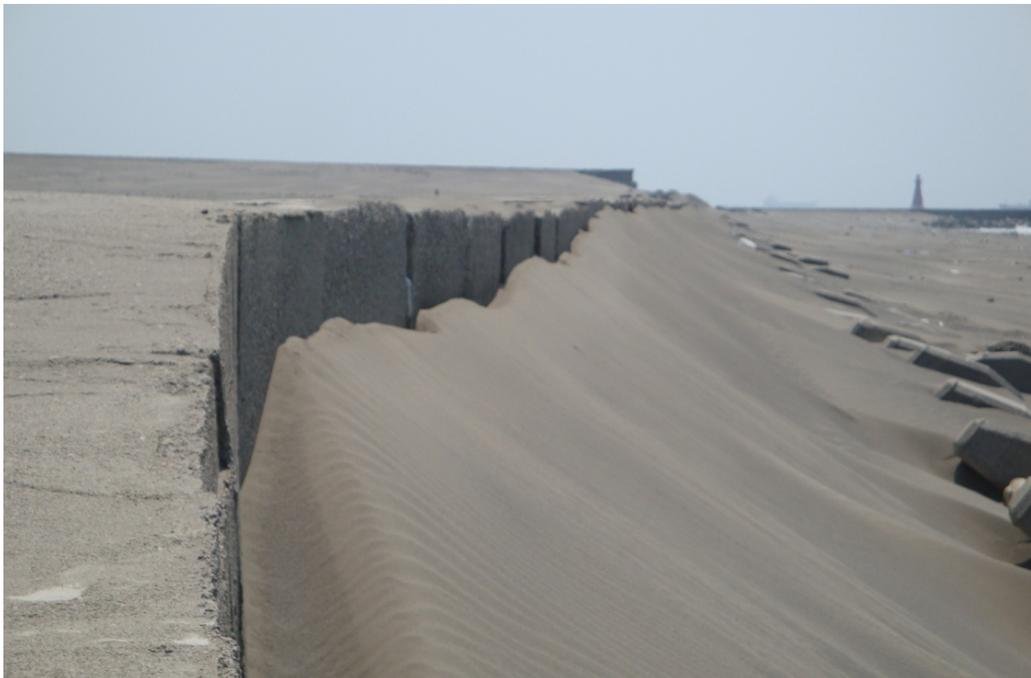
照片 2-9 臺中港北防波堤位置 8 飛沙淤積圖 (2011/05)
