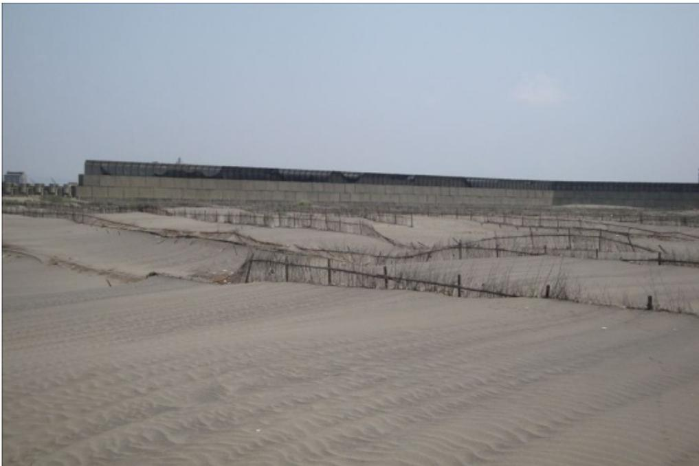
照片 2-5b 臺中港北防波堤位置 4 飛沙淤積圖 (2011/05)
