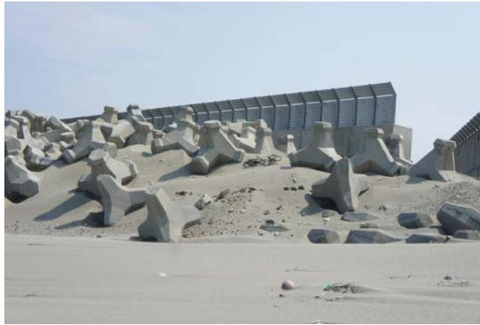
照片 8-13 第三期工程於二期圍堤堤頂處設置長防風柵欄 (2011/10)
