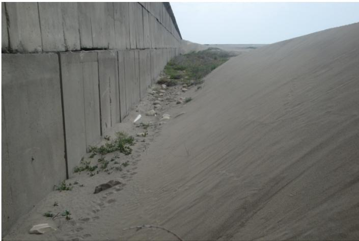
照片 8-11 第 III 區擋風牆牆角淤沙區 (2011/10)
