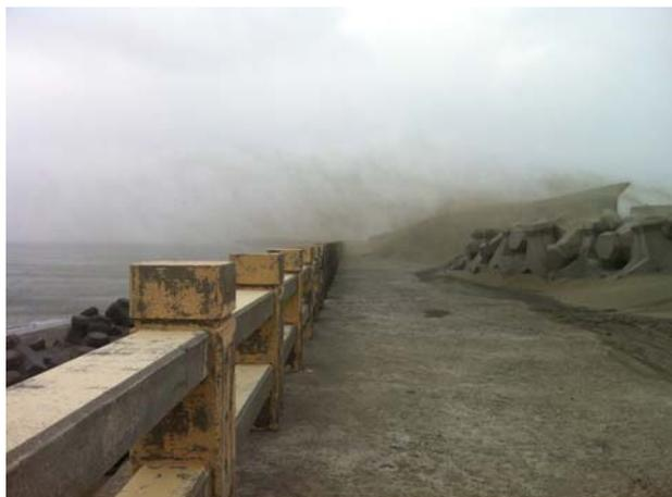
照片 8-18 第三期工程北防波堤堤址處淤沙 (2011/12)
