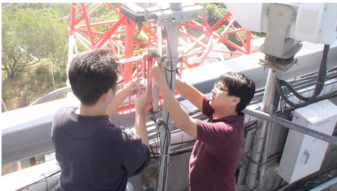
圖 6.8 金門太武山接收站 AIS 天線安裝
