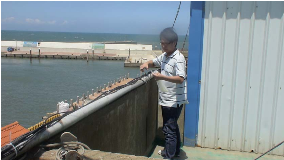
圖 6.4 苗栗外埔接收站 AIS 天線與主機配線
