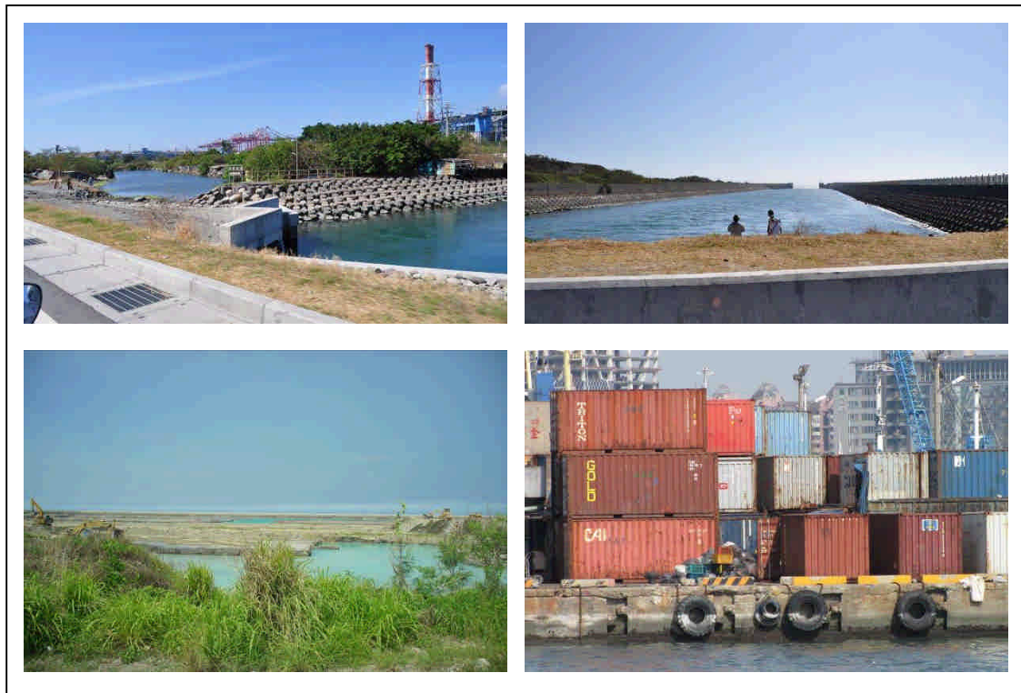
圖4.7 高雄港埠周邊水泥化渠道(右)及潛在之生態補償區域(左)
