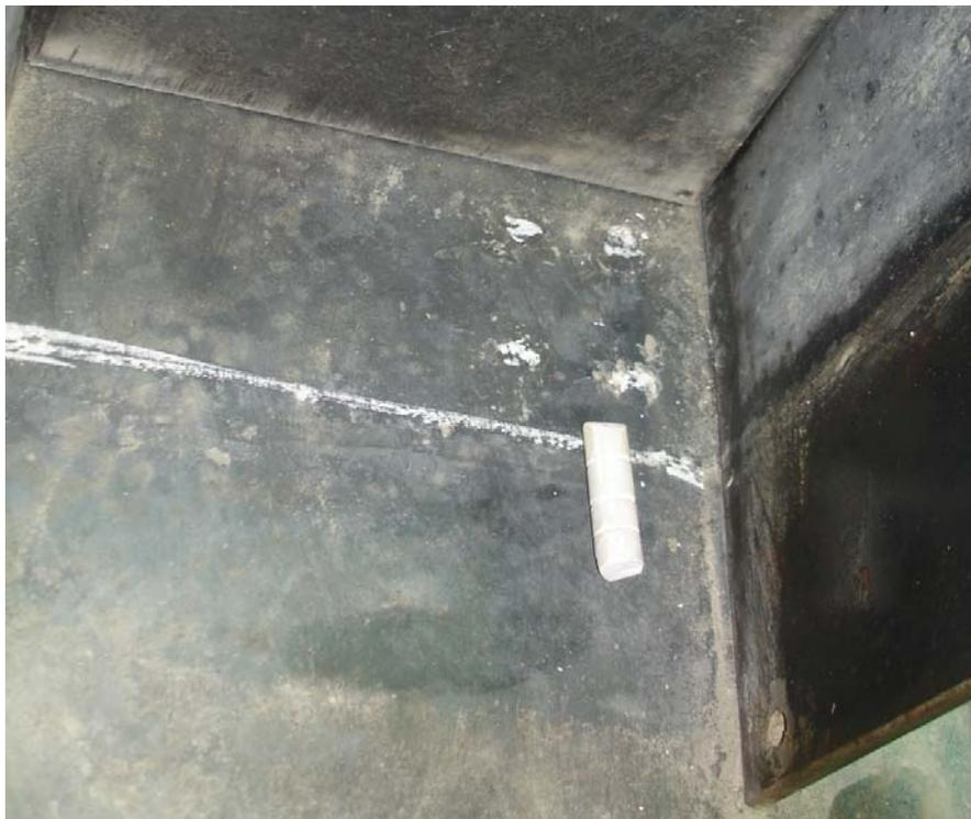
圖 10.11 以粉筆在底板上標記鋼筋位置
