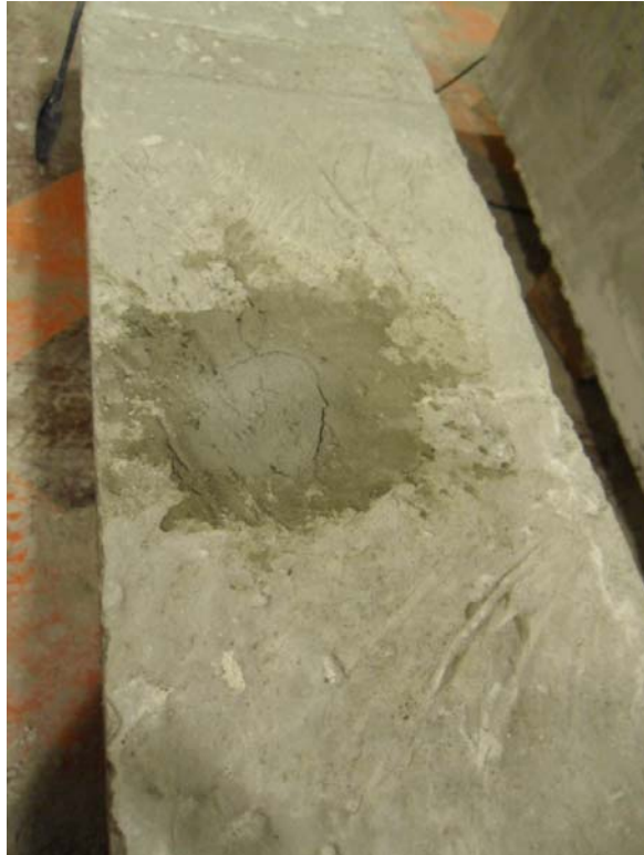
圖 4.19 以大面積修補填補工法完成圖
