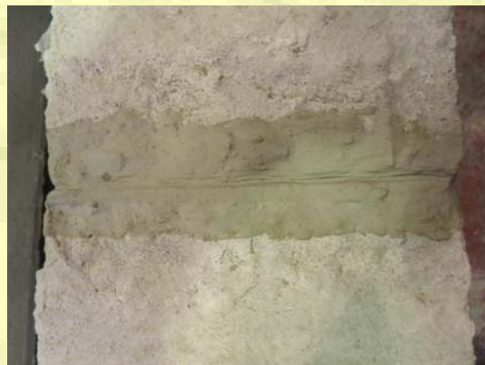
以修補材料表面塗封工法完成圖
