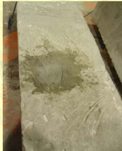
以大面積修補填補工法完成圖
