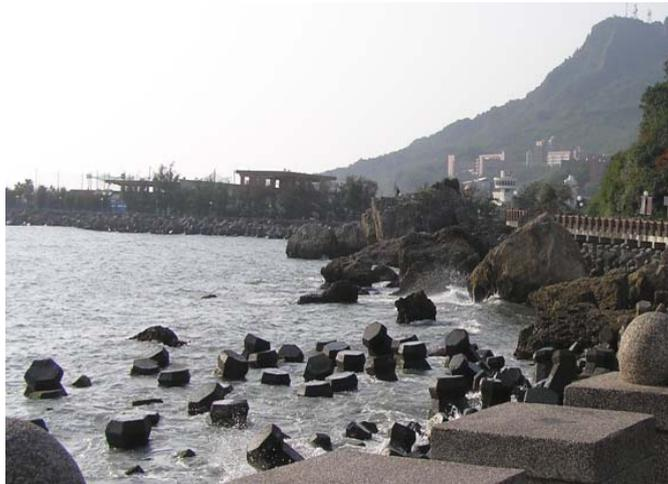
圖 4.19 浸泡於水中的消波塊
