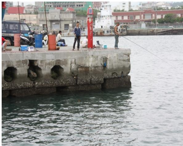
圖 4.9 孔洞型岸壁設計(花蓮港)
