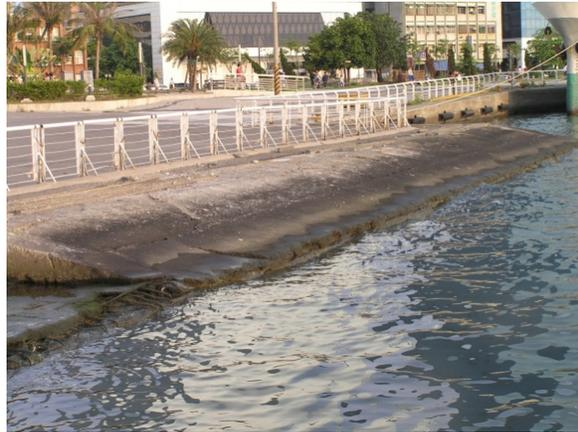
圖 4.16 真愛碼頭左岸的緩斜坡護岸
