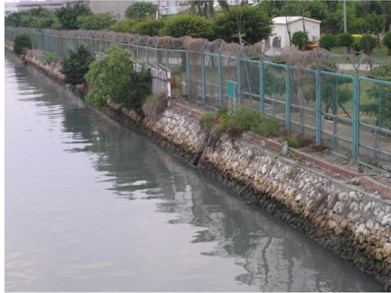
圖 4.17 第五船渠 泥漿石砌護岸
