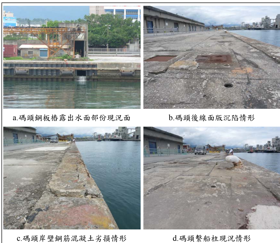
圖 3.30 花蓮港 5 號碼頭現況情形
