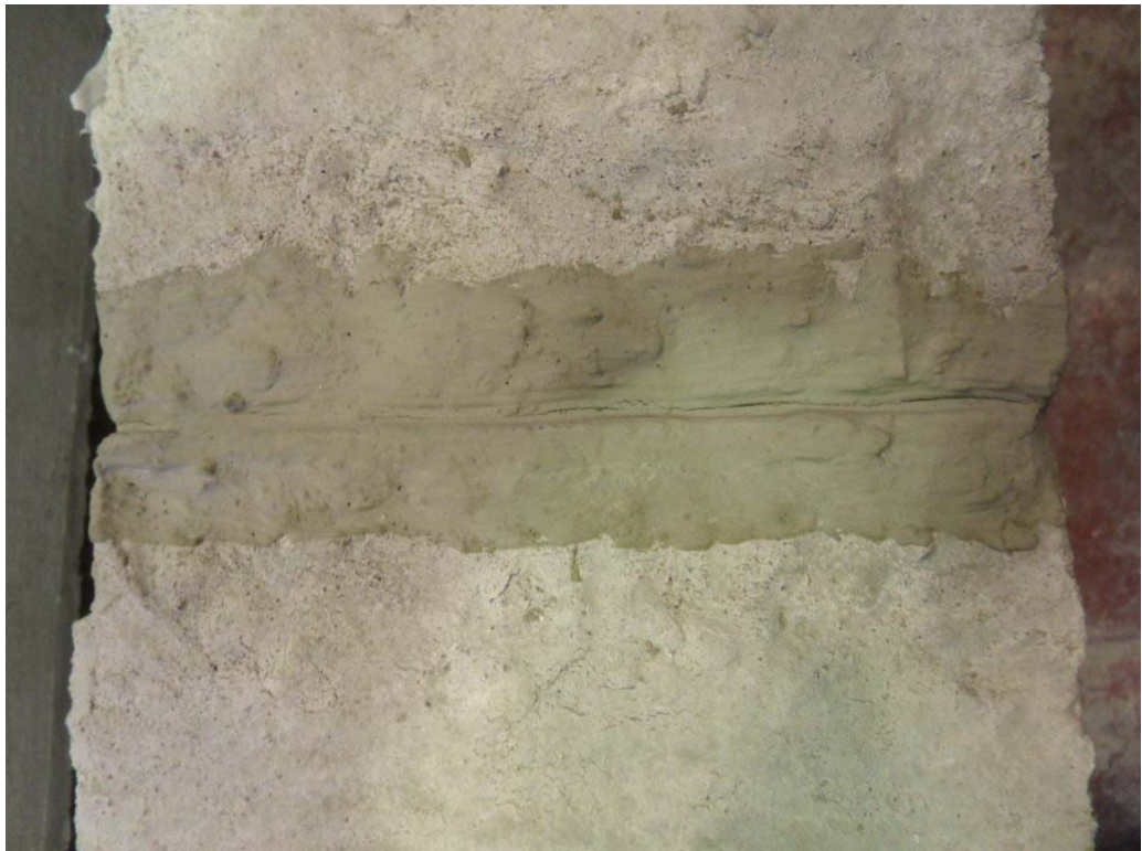
圖 5.71 以修補材料表面塗封工法完成圖
