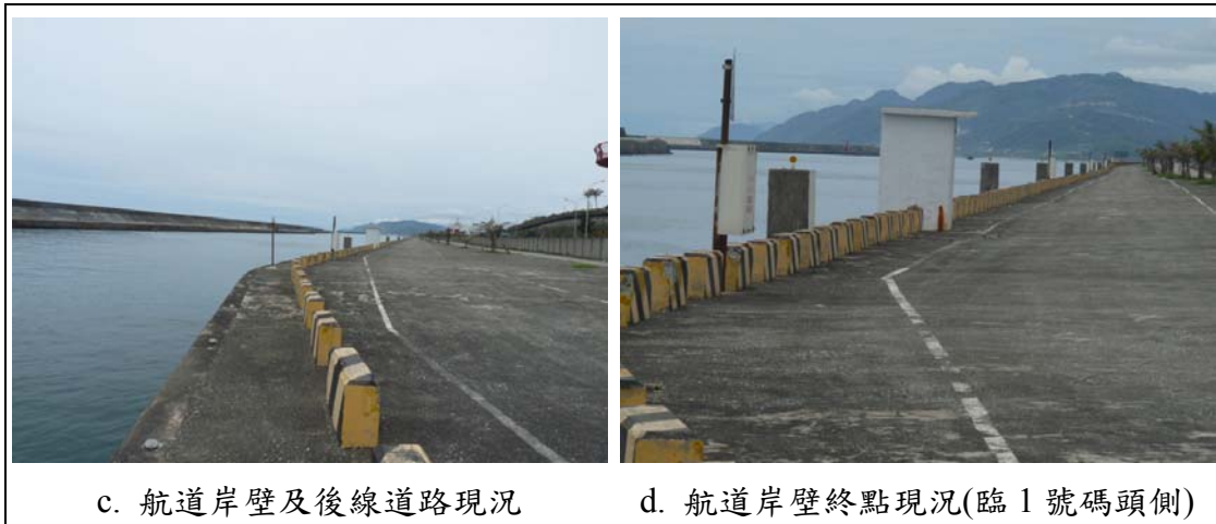
圖 3.39 花蓮港航道岸壁現況情形
