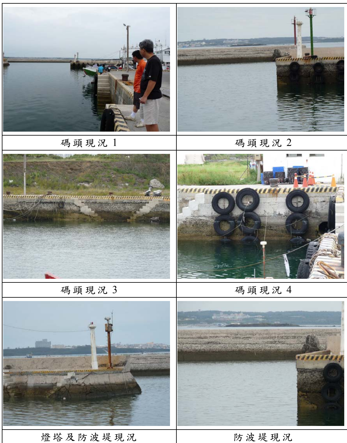
圖 3.68 嵵裡漁港現況情形 (100.6.23)
