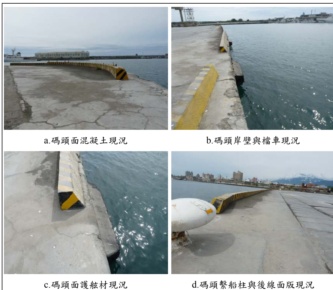
圖 3.37 花蓮港 9 號碼頭現況情形
