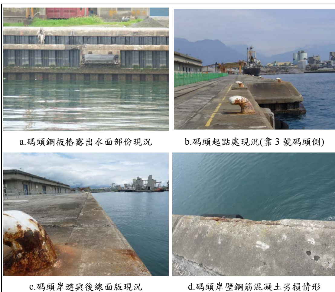
圖 3.29 花蓮港 4 號碼頭現況情形
