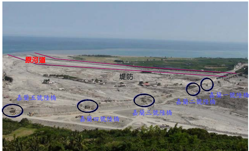
圖 3.12 河道拓寬橋梁路堤及護岸沖毀之案例
