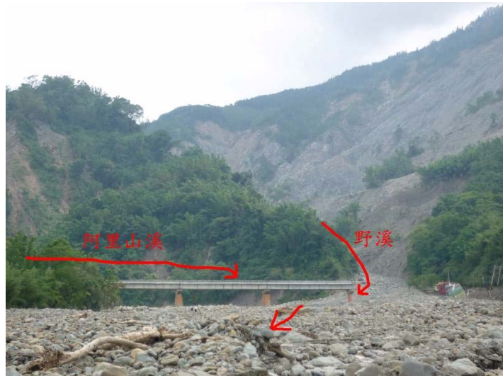
圖 3.16 邊坡滑落推擠橋梁破壞之案例
