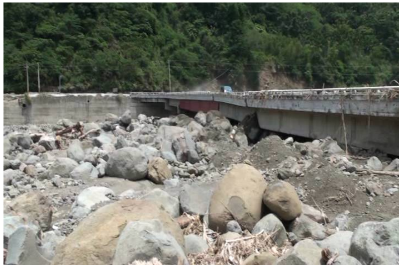
圖 3.13 通水斷面不足上部結構損壞之案例
