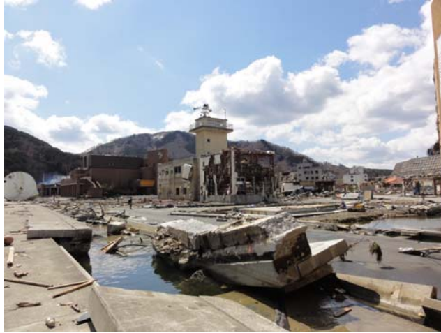
圖 5.11 碼頭堤面破壞(女川港)
