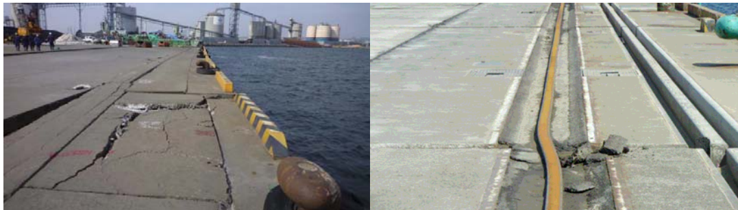
圖 5.8 碼頭與岸壁遭海嘯淘刷後受損情形(左：鹿島港，右：相馬港)
