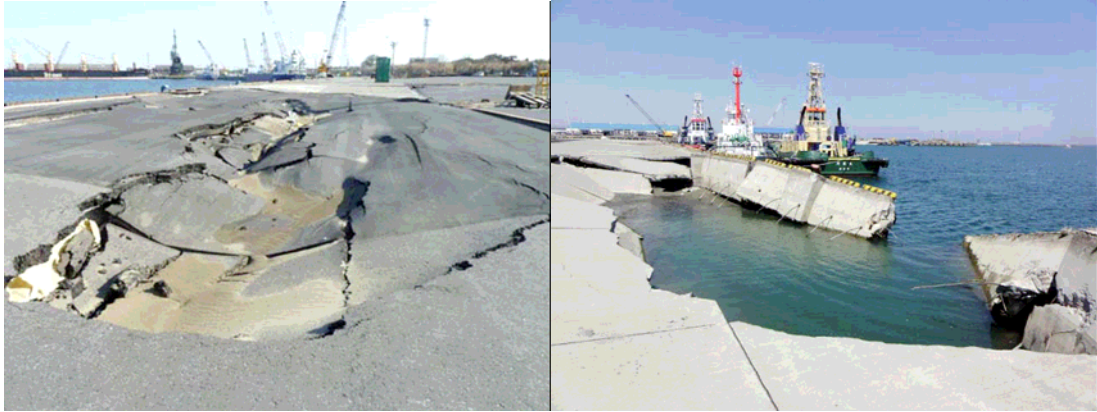
圖 5.8 碼頭與岸壁遭海嘯淘刷後受損情形(左：鹿島港，右：相馬港)
