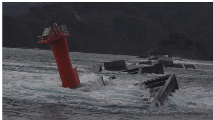
圖 5.6 防波堤沉箱遭海嘯破壞後受損情形(八戶港)
