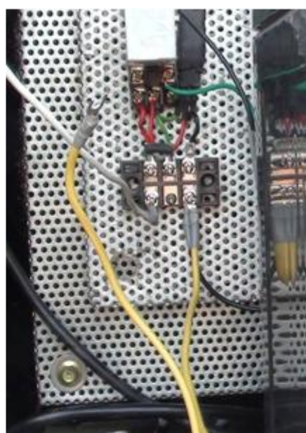
(2)拔除迴路接頭進行測試
