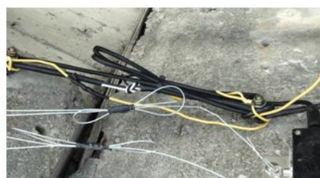
(8) 遇伸縮縫時，利用束制器於伸縮縫二端束制 傳輸線及電源線
