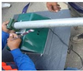
(6) 確認警示燈外接電源線
