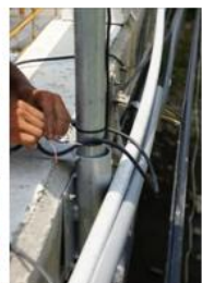
(6) 將電源線與警示燈 外接電源線搭接
