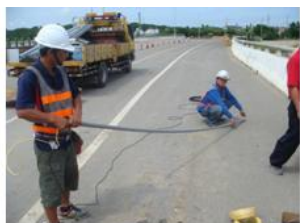
(1) 將傳輸線及電源線套入PVC管
