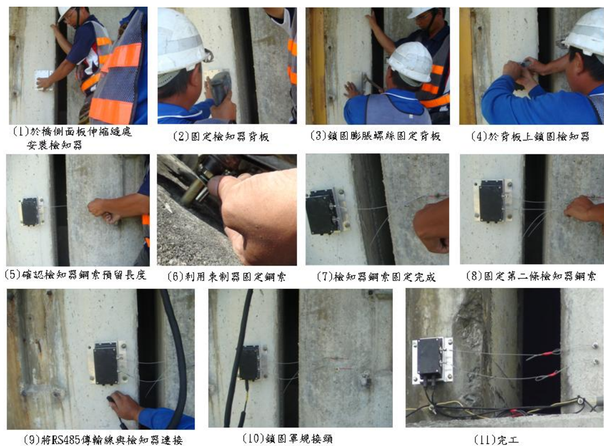
圖 9 鎖固檢知器
