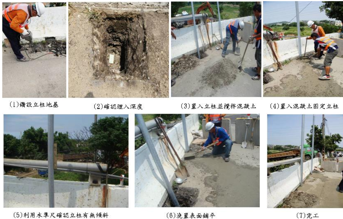
圖 25 架設各設施之支撐立柱
