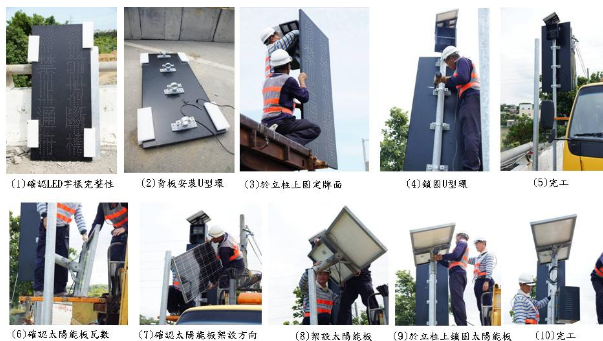
圖 5 安裝 LED 牌面及太陽能板
