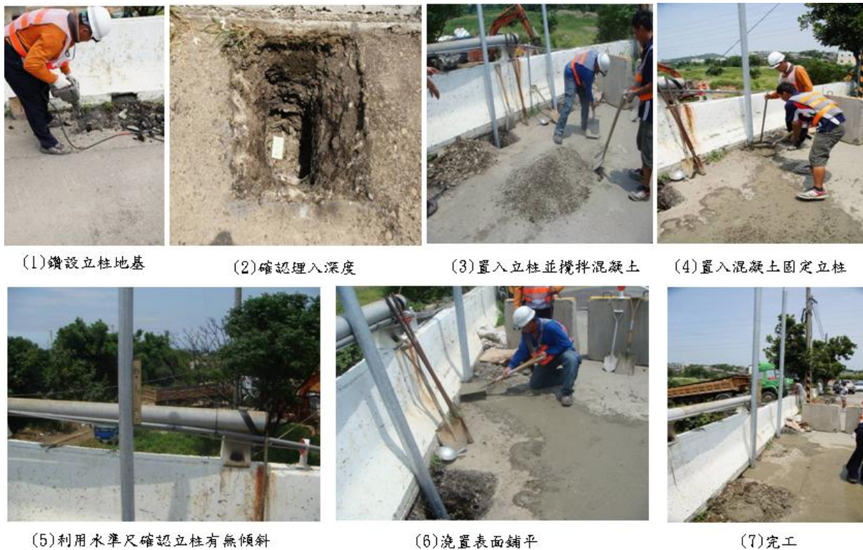
圖 3 架設各設施之支撐立柱
