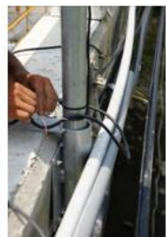
(6) 將電源線與警示燈 外接電源線搭接
