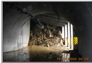
台 9 線 165.8K 明隧道崩塌
