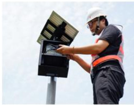
(2) 將電池接頭接於充放電控制器
