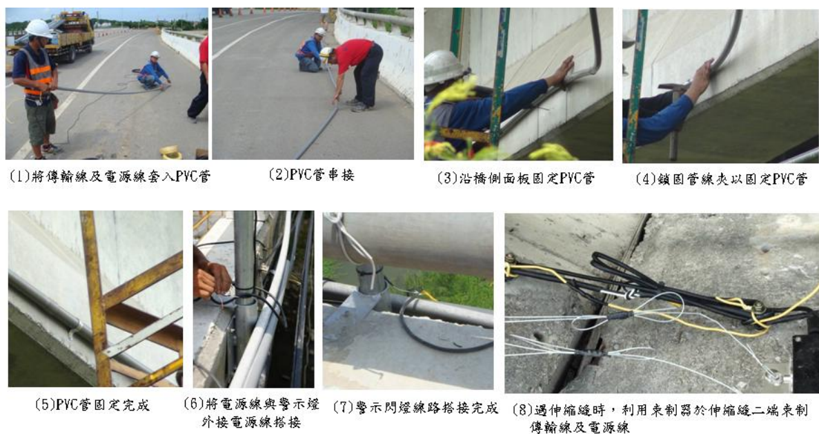
圖 8 固定傳輸線（或電纜線）及電源線
