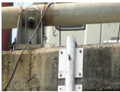
(4) 警示燈立柱架設完成
