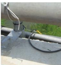
(7) 警示閃燈線路搭接完成
