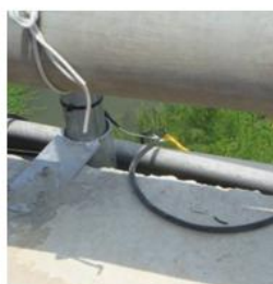
(7) 警示閃燈線路搭接完成
