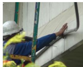
(3) 沿橋側面板固定PVC管
