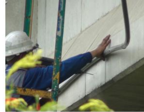
(6) 固定RS485傳輸線及警示燈電源線（以PVC管保護）
