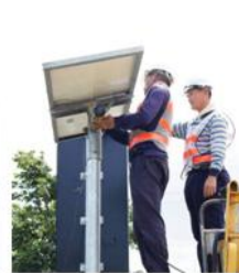
(9) 於立柱上鎖固太陽能板
