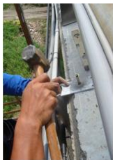
(2) 鎖固上方面板膨脹螺絲
