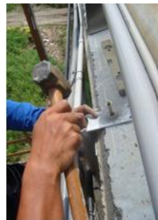
(2) 鎖固上方面板膨脹螺絲
