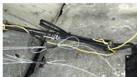
(8) 遇伸縮縫時，利用束制器於伸縮縫二端束制 傳輸線及電源線
