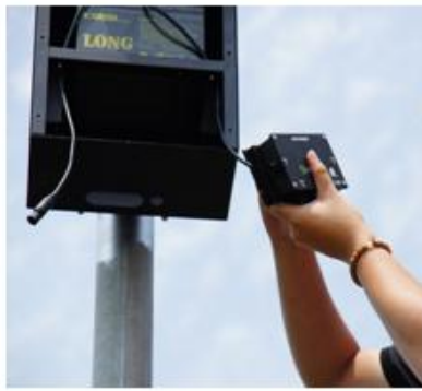
(1) 將太陽能板接頭接於 充放電控制器
