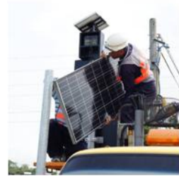
(7) 確認太陽能板架設方向
