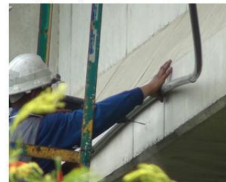
(6) 固定RS485傳輸線及警示燈電源線（以PVC管保護）
