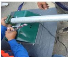
(6) 確認警示燈外接電源線
