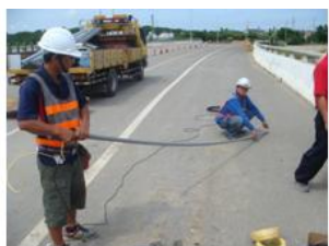
(1) 將傳輸線及電源線套入PVC管
