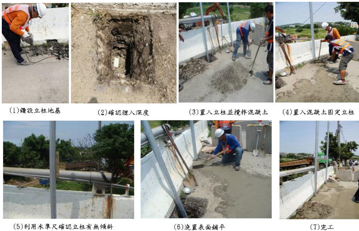
圖 15 架設各設施之支撐立柱
