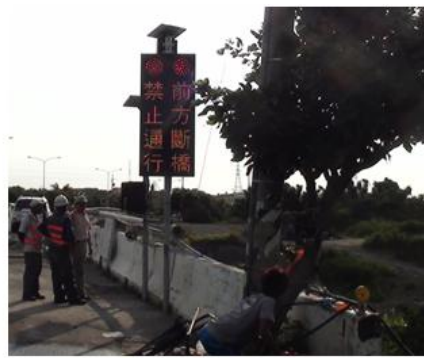
(2) 測試LED牌面作動情形
