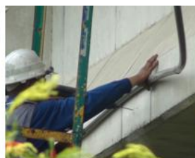
(3) 沿橋側面板固定PVC管
