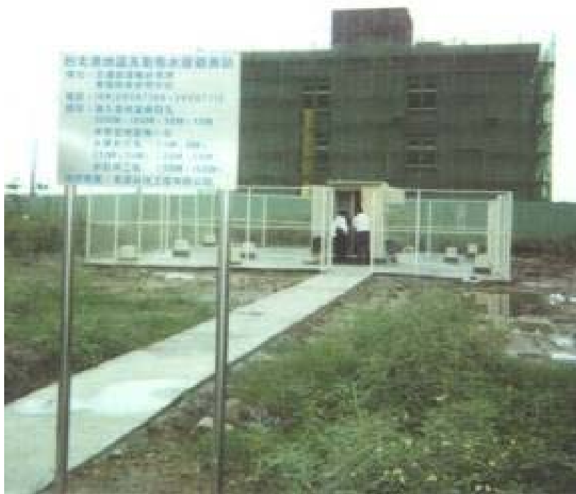
圖 2-11 臺北港區地震分層監測站設置完成外貌狀況
