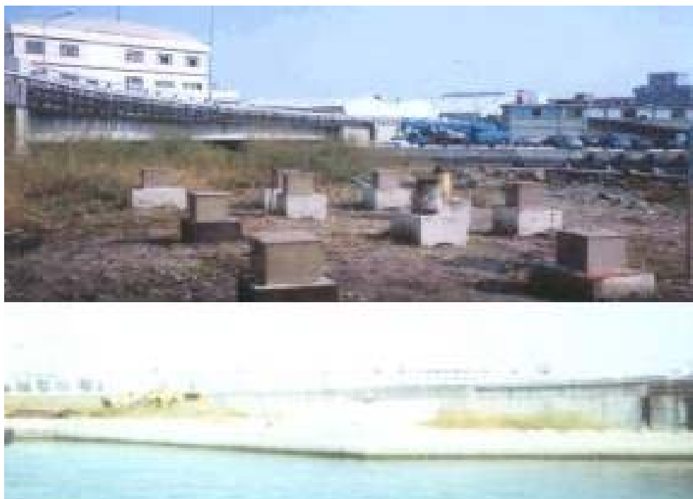
圖 2-6 安平港區地震分層監測站設置完成外貌狀況
