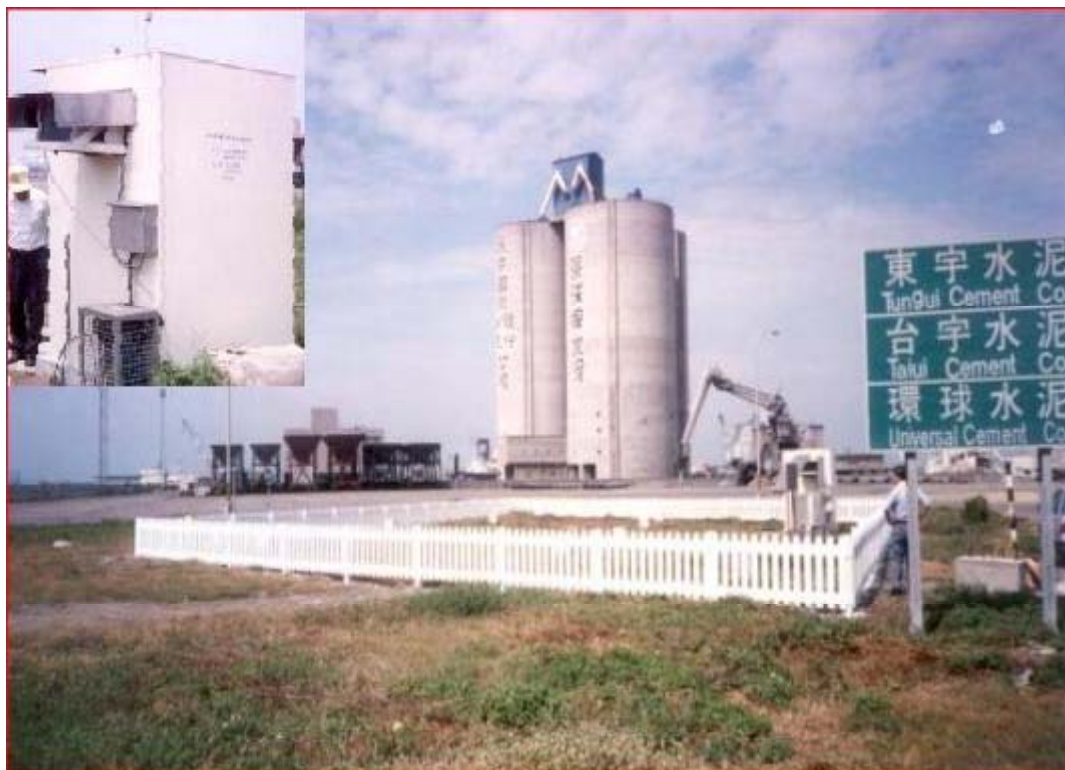
圖 2-7 臺中港區地震分層監測站設置完成外貌狀況
