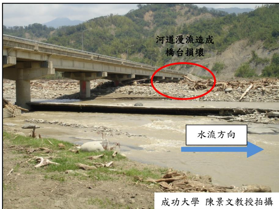
圖 4.5 台 21 線 235K+585 楠梓仙溪橋左側橋台後方河道漫流
