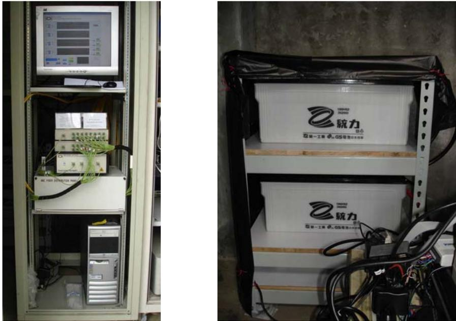
圖 2.3 現場光纖監測儀器擷取系統圖
