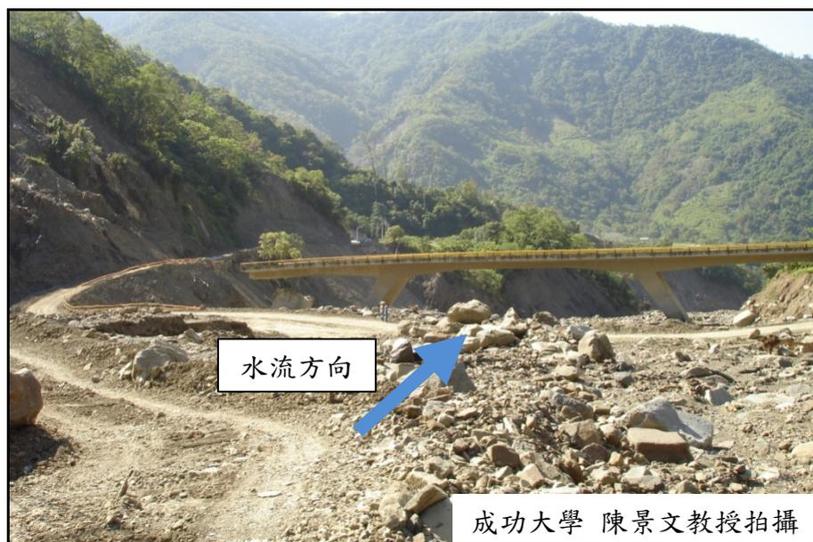
圖 4.16 台 20 線 87K+300 塔拉拉魯芙溪橋左側橋台損毀
