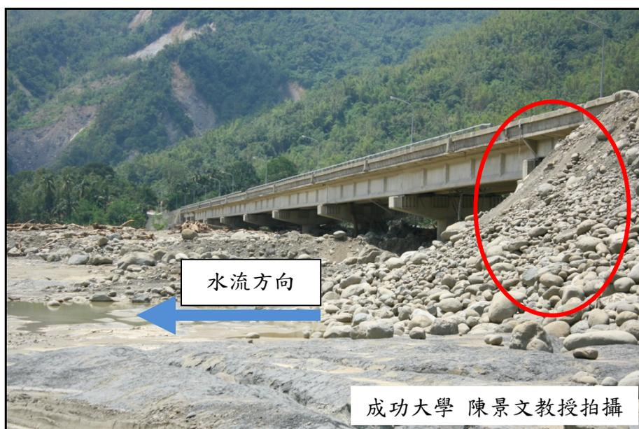
圖 4.6 台 21 線 235K+585 楠梓仙溪橋左側橋台後方河道漫流
