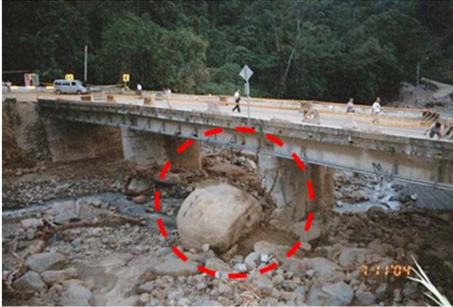
圖 4.7 橋墩受土石流巨礫撞擊破壞之實景
