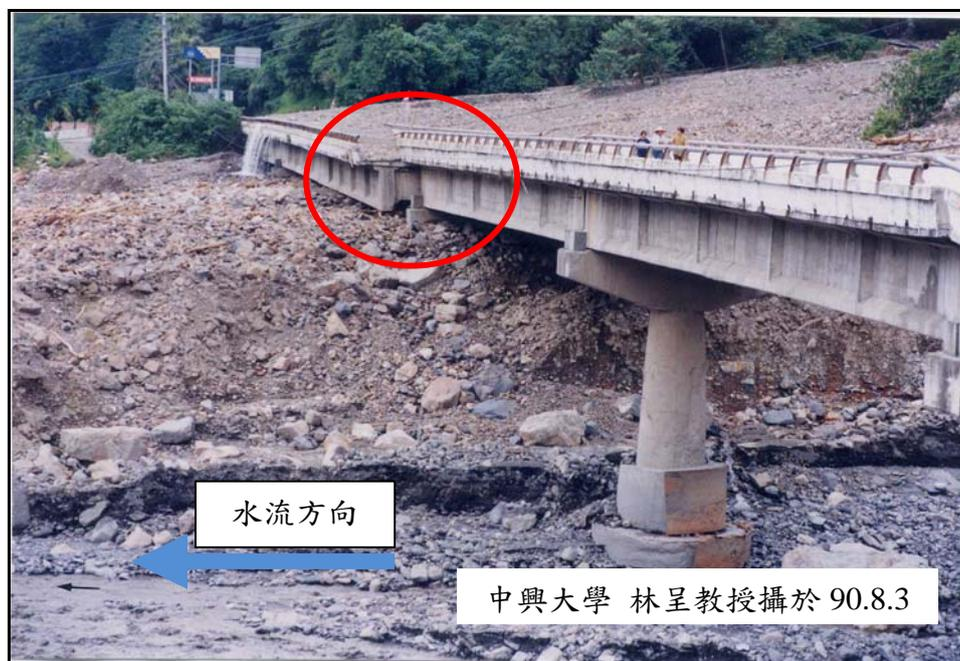
圖 4.12 台 21 線 98K+070 十八重溪橋土石堆積推擠橋面版
