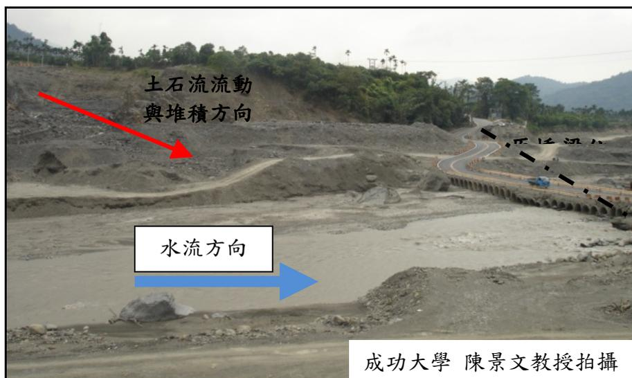
圖 4.8 台 27 線 3K+480 新發大橋土石淤滿擠壓主河道
