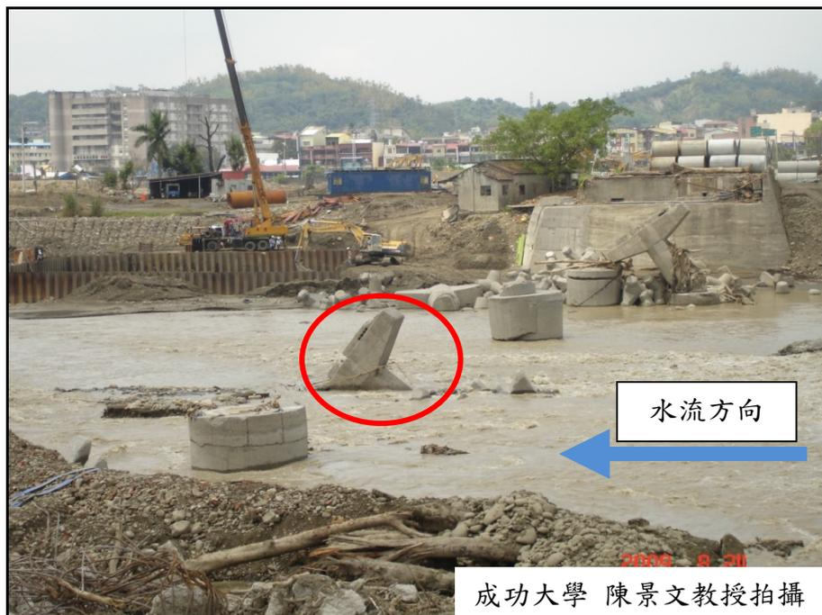
圖 4.2 台 28 線 30K+500 旗尾橋橋墩傾倒破壞
