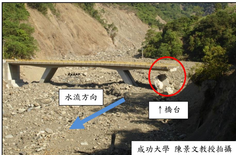
圖 4.15 台 20 線 87K+300 塔拉拉魯芙溪橋左側橋台損毀
