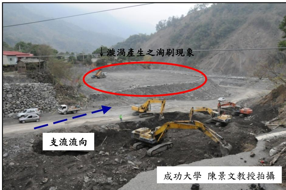
圖 4.11 主、支流匯流處產生漩渦侵蝕周遭邊坡
