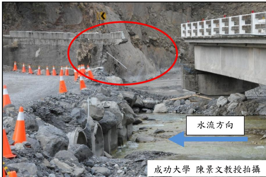
圖 4.4 台 20 線 103K+360 復興橋橋台後方遭淘刷破壞
