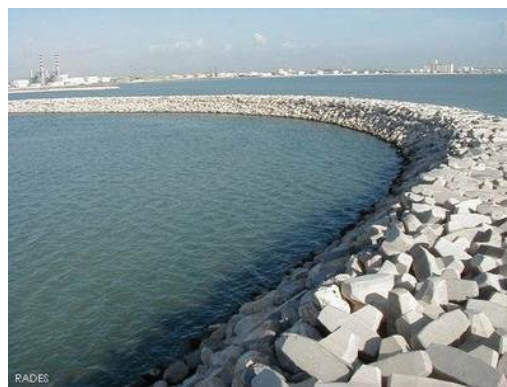
(b)施工後海岸護岸的實景
