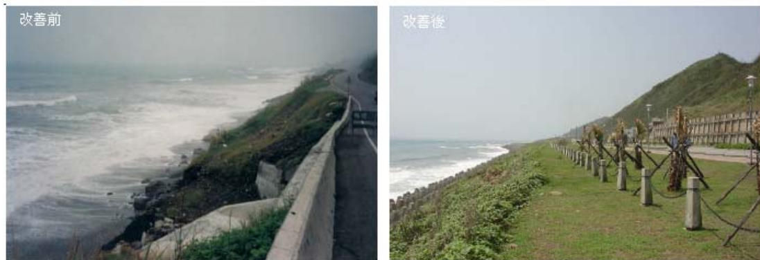
圖 5.3.17 臺 11 線大坑段邊坡改善前後對照圖(地工技術，第 131 期)
