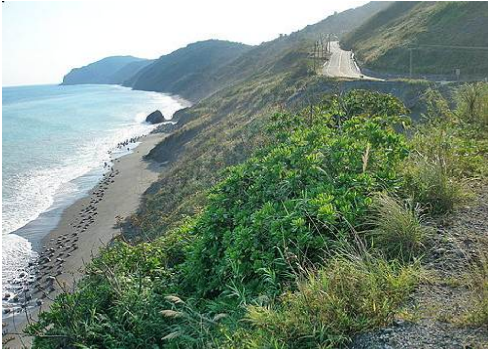
圖 5.3.6 海岸公路邊坡前沙灘以消波塊保護
