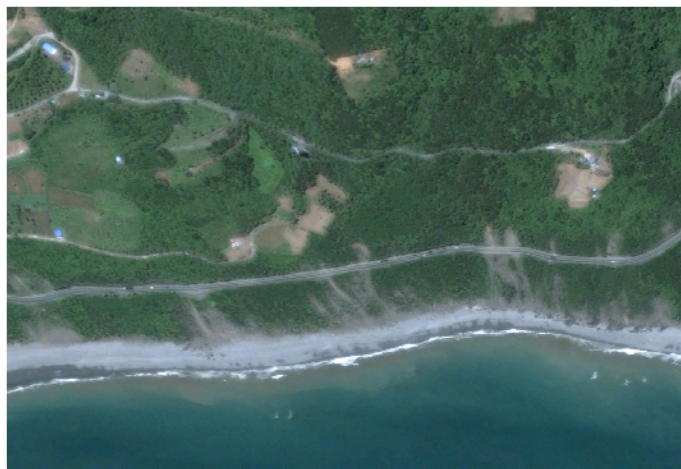
圖 5.3.12 公路海側邊坡受逕流沖蝕情形
