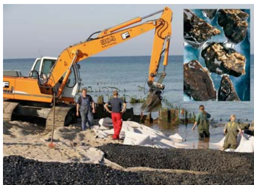
(a)德國生態礁塊施工
