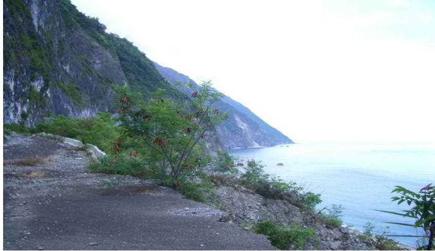
圖 5.3.4 臺 9 線舊蘇花公路段廢棄公路持續崩塌陷落情形
